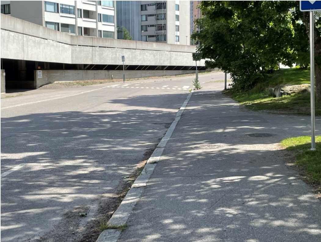
Kuva 7.12. Punakiventien ylittävä korotettu suojatie Punakivenkujan risteyksessä kuvattuna koulun edustalta Vuosaarentien suuntaan.
