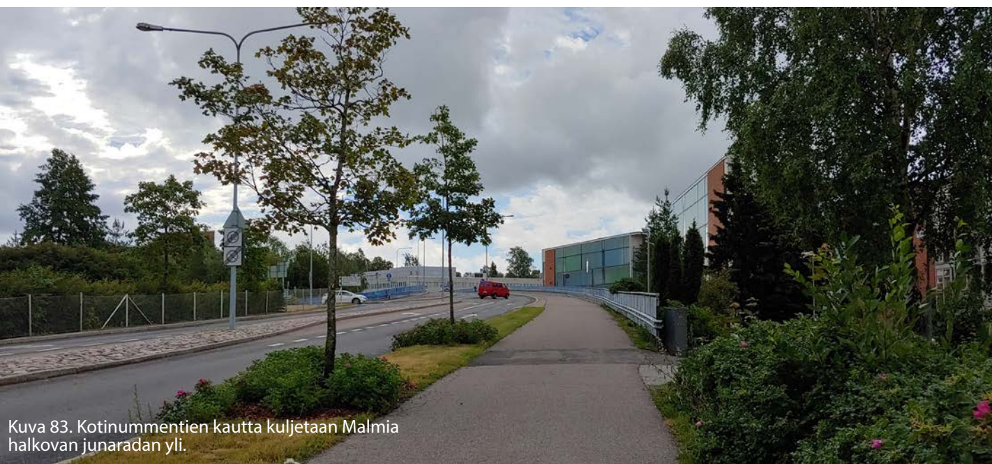
Kuva 82 Kaupparaitin päällystys on paikoin heikossa kunnossa.
