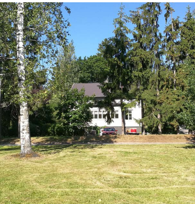
Kuvat 25 ja 26. Ormusmäentien rakennuskanta koostuu kerrostalojen lisäksi pientaloista.
