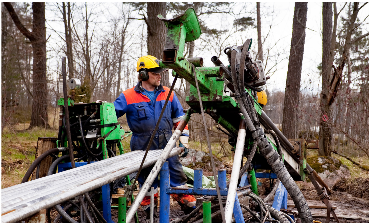
Kuva 15: Länsimetron Karhusalmen aluetta tutkittiin kalliokairaamalla, 2010, ROCKPLAN kuva-arkisto, Juha Nenonen
