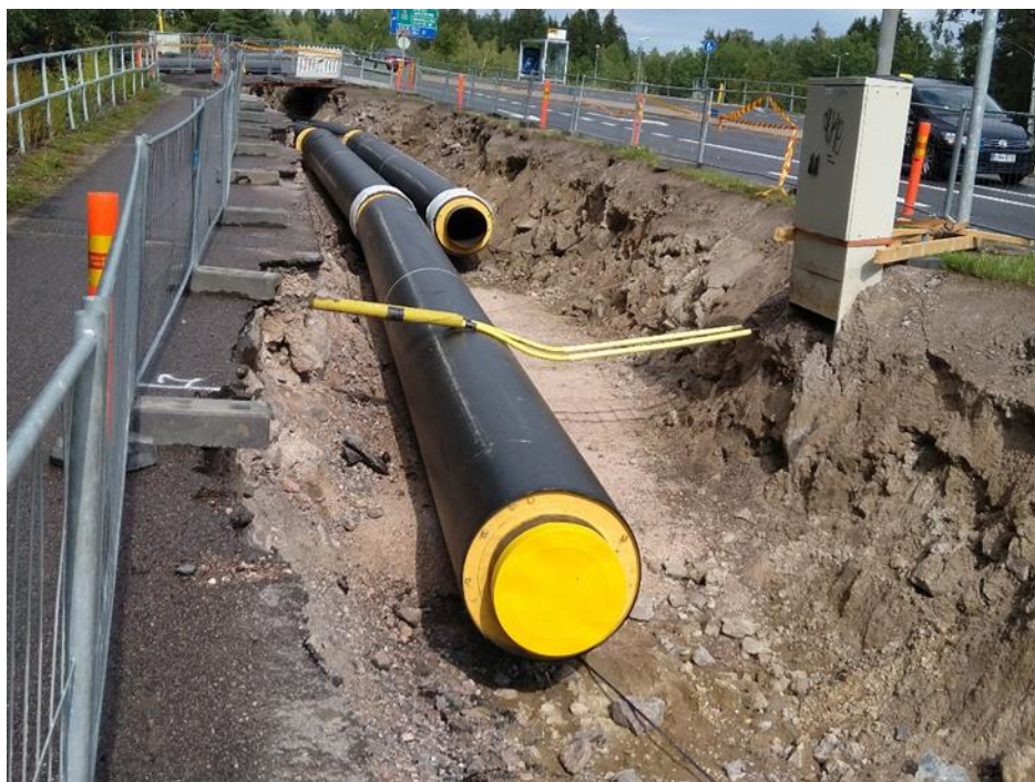
Kuva 9. Lämmönjakeluverkoston ja -kaivannon rakenne (2Mpuk)
