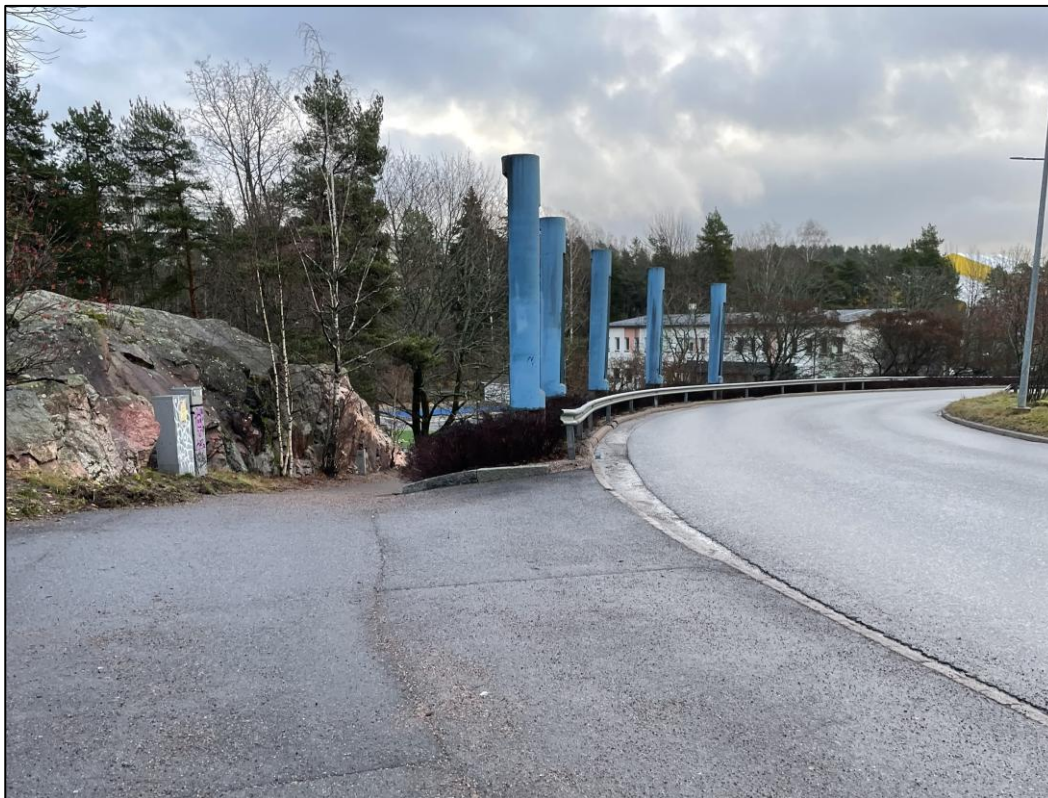
Kuva 7.6. Kuvassa on Salpausseläntiestä haarautuva jalkakäytävä koulun ja päiväkodin suuntaan koulun länsipuolella Pihlajiston suunnasta kuvattuna.
