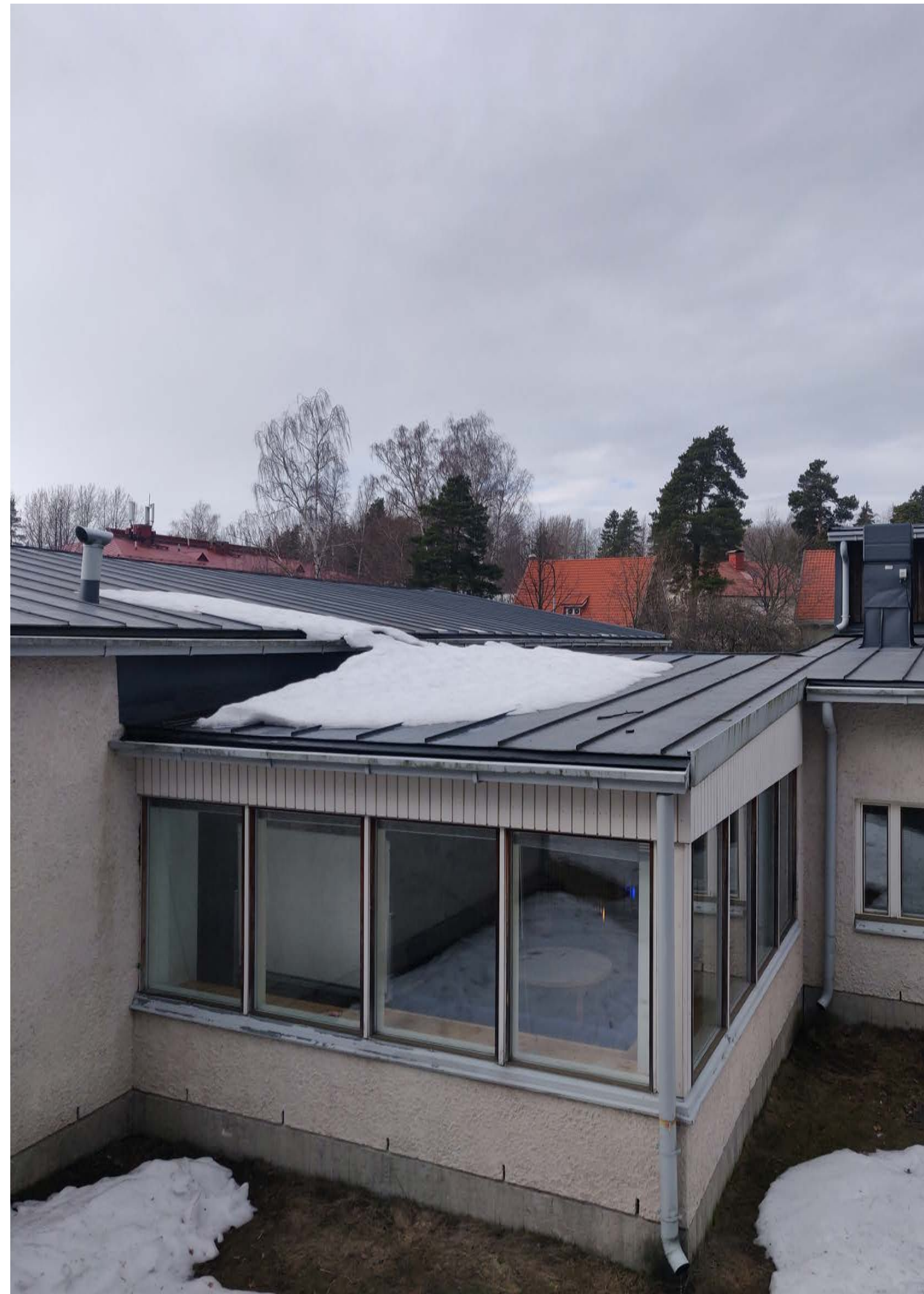
Kuva 36. Rakennuksen vesikate on pääosin konesaumattua peltiä.
