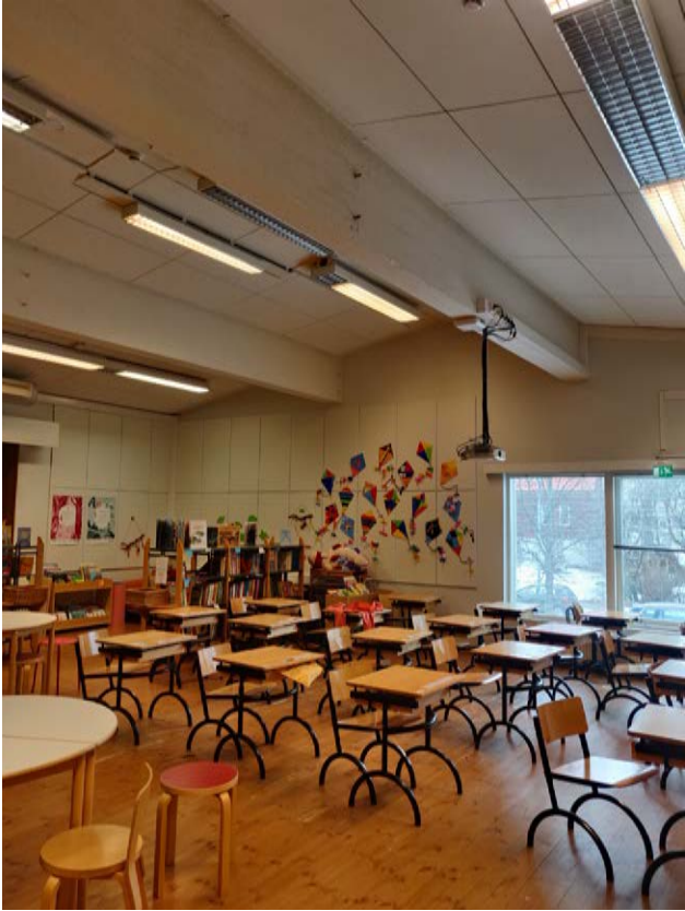
Kuva 28. Yläpohjia kannattelevia betonipalkkeja rakennuksen alkuperäisessä osassa.
