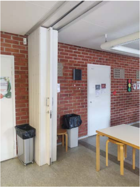
Kuva 43. Rakennuksen alkuperäisen osan tiiliseiniä.
