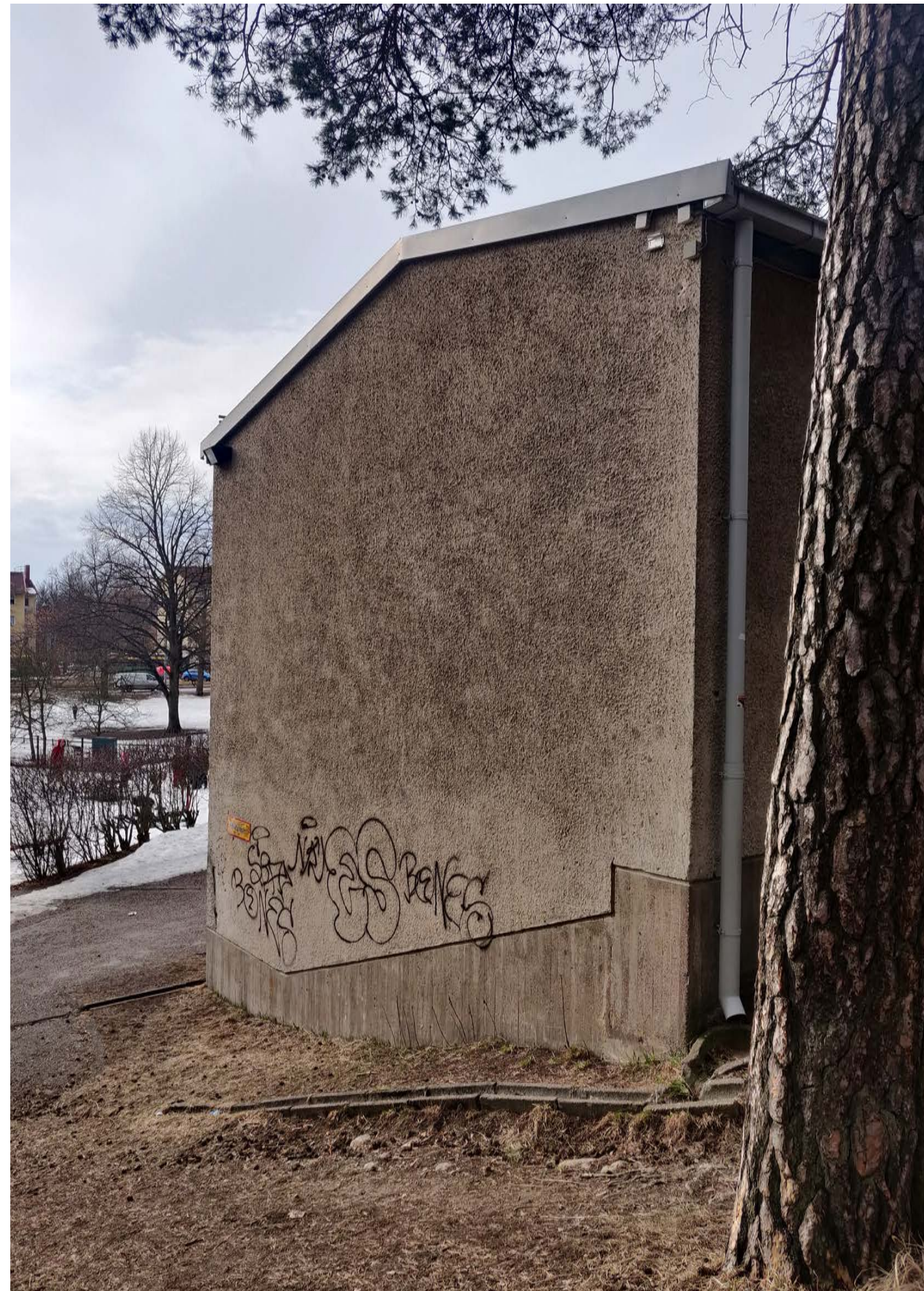
Kuva 18. Rakennus on perustettu osittain rinteeseen.
