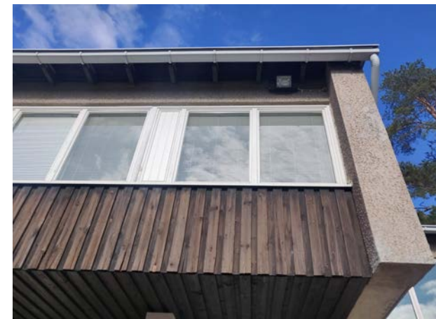
Kuva 31. Erkkerin julkisivupinnan lomalaudoitusta.
