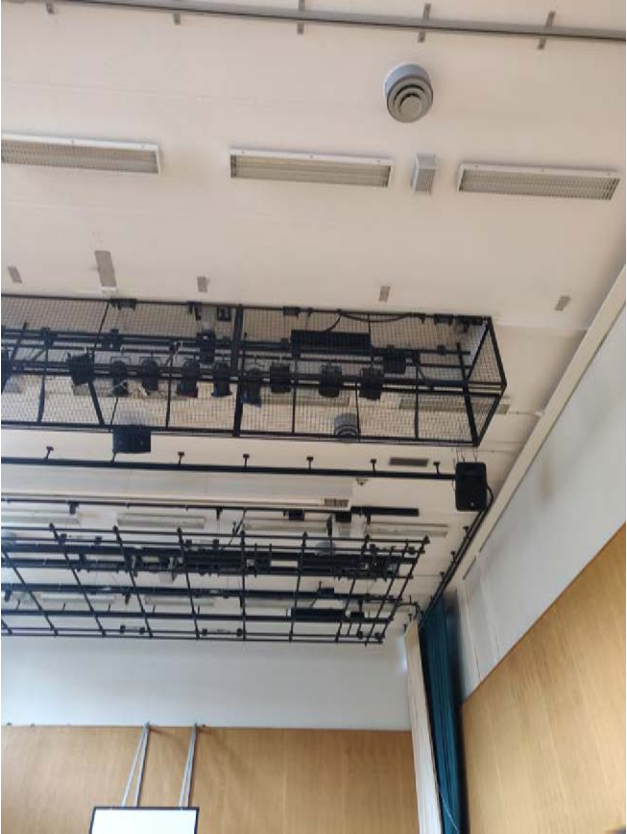
Kuva 27. Liikuntasalin yläpohjan ontelolaattoja.
