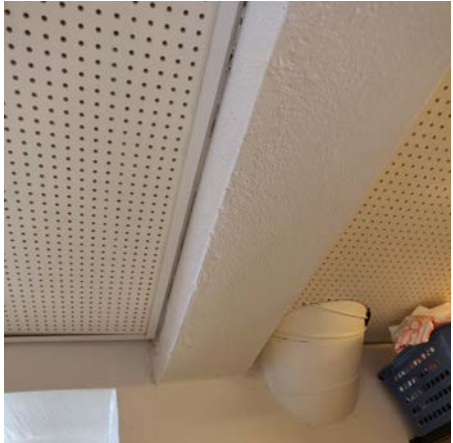
Kuva 24. Välipohjaa kannatteleva paikallavalettu teräsbetonipalkki rakennuksen alkuperäisessä osassa.
