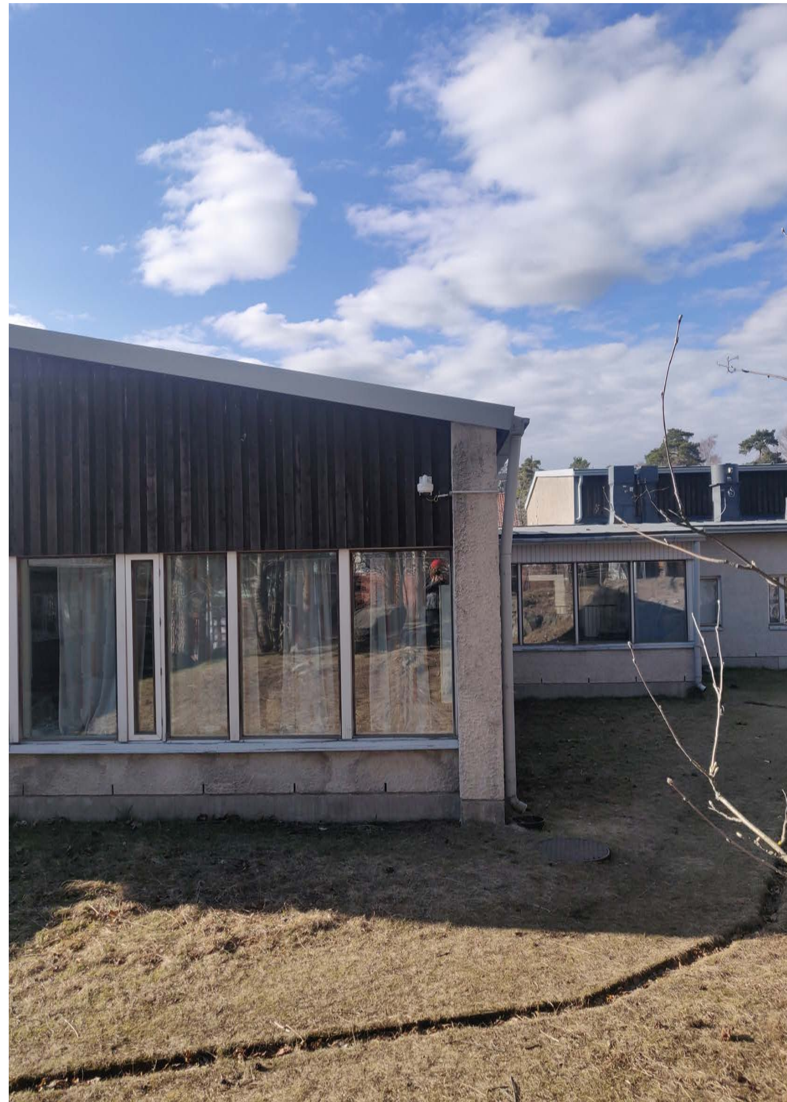
Kuva 29. Rakennuksen toisen kerroksen julkisivua.
