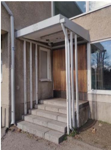
Kuva 37. Alkuperäisen osan katos.
