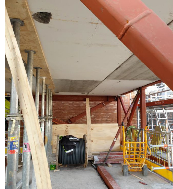
Kuva 7. Välipohjissa uudelleenkäytettyjä ontelolaattoja. (Kuva: Noora Khezri, Mad arkitekter)
