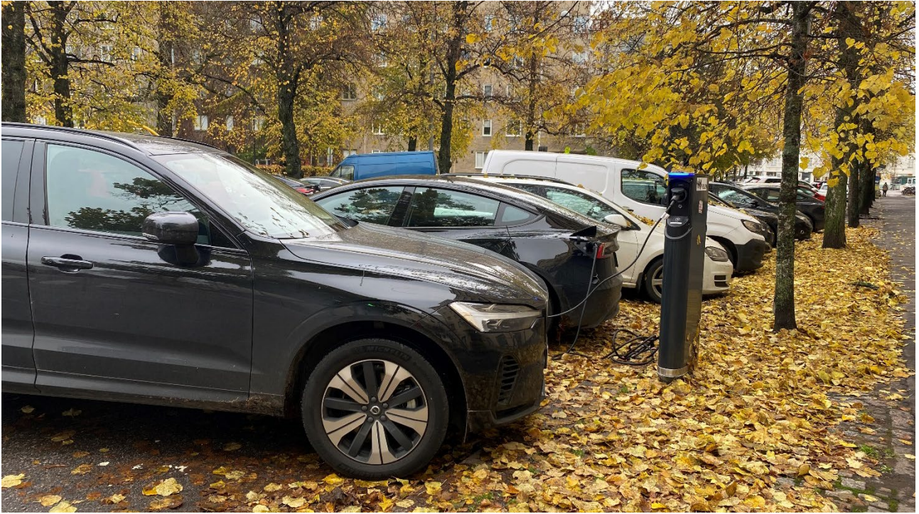
Kuva 5. Henkilöautoja latauksessa Töölössä. Henkilöautoille suunniteltu julkinen latausinfra ei sovellu työmaa- tai kunnossapitokaluston lataukseen. (Kuva: Johanna Nyberg, WSP)
