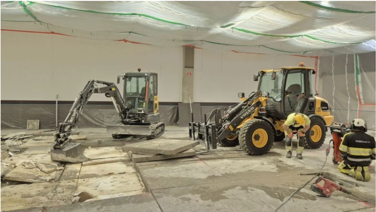
Kuva 6. Päästötöntä, sähkökäyttöistä kalustoa talonrakennustyömaalla. Lähde: Volvo.
