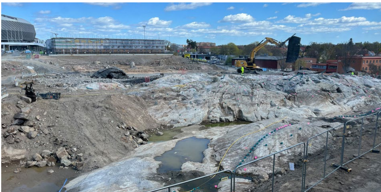
Kuva 7. Tukholman Slakthusområdetin kaupunkikehitystyömaa on toteutettu fossiilivapaasti. (Kuva: Tukholman kaupunki, 2024)
