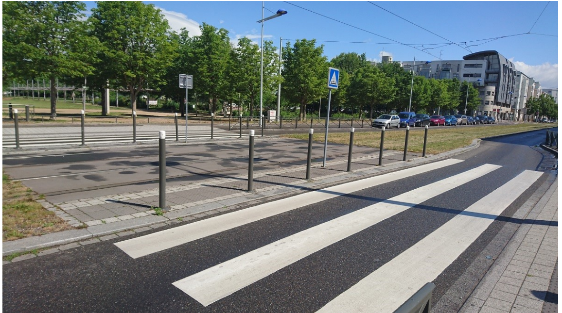
Kuva 5 Raitiotien ylityspaikka Strasbourgissa (Kuva: Niko Setälä)
