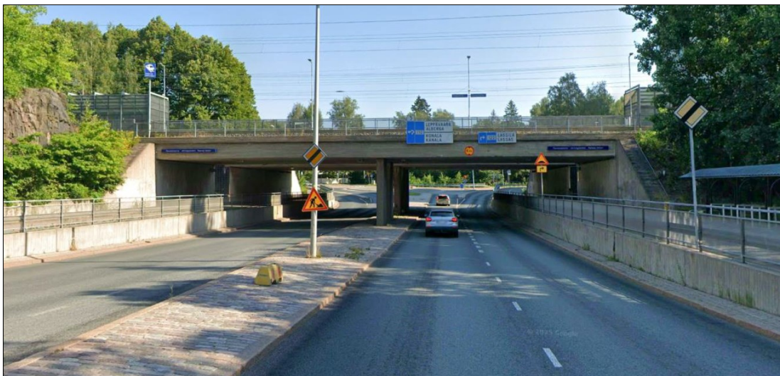
Kuva 54. Pitäjänmäentien aikulku muodostaa painanteen, jossa ei ole maanpäällistä tulvareittiä. Vesi voi kerääntyä ja lammikoitua aikulkuun rankkasateiden aikana (kuva: Google Maps).
