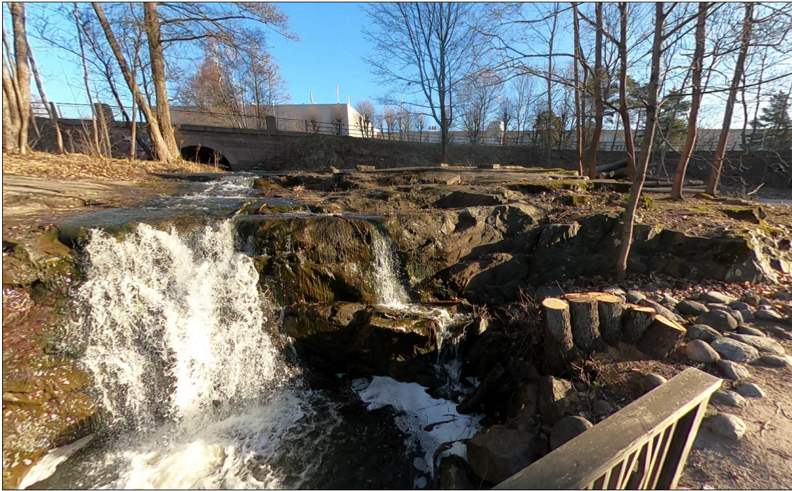
Kuva 17. Strömbergin puisto huhtikuussa ennen kalatien rakentamista. Putous aiheutti nousuesteen kajoille.
