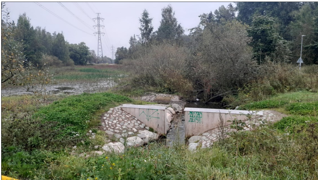
Kuva 64. Esimerkki virtaamansäätörakenteesta, jossa on suorakulmainen virtausaukko. Uoman pohjaan ei tehdä muutoksia tai kynnyksiä. Kuva on vastarakennetusta Helsingin Mustapuron vesienhallintahankkeesta.
