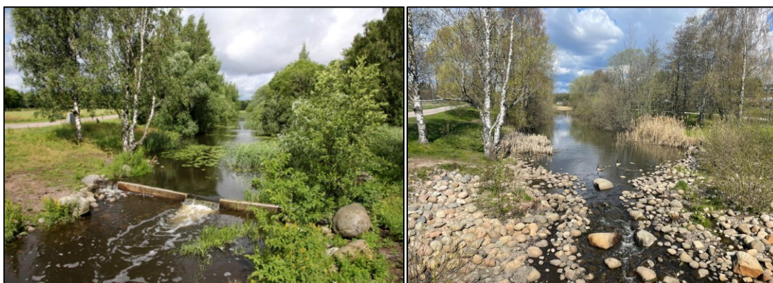
Kuva 27. Trumpetti puiston betonipato (vas.) (kuva: Helsingin kaupunki, 2020 11 ) muutettiin luonnonmukainen koskeksi (oik.) (kuva: Sitowise, 2025).
