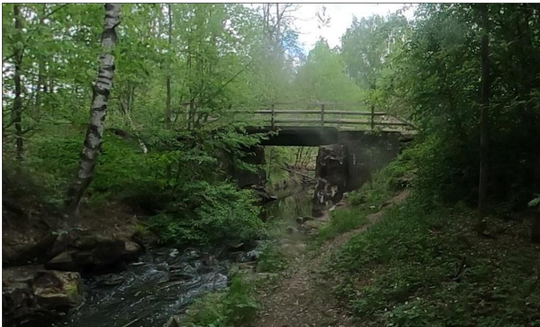
Kuva 67. Lassilan ulkoiluraitin silta kuvattuna alavirran puolelta.
