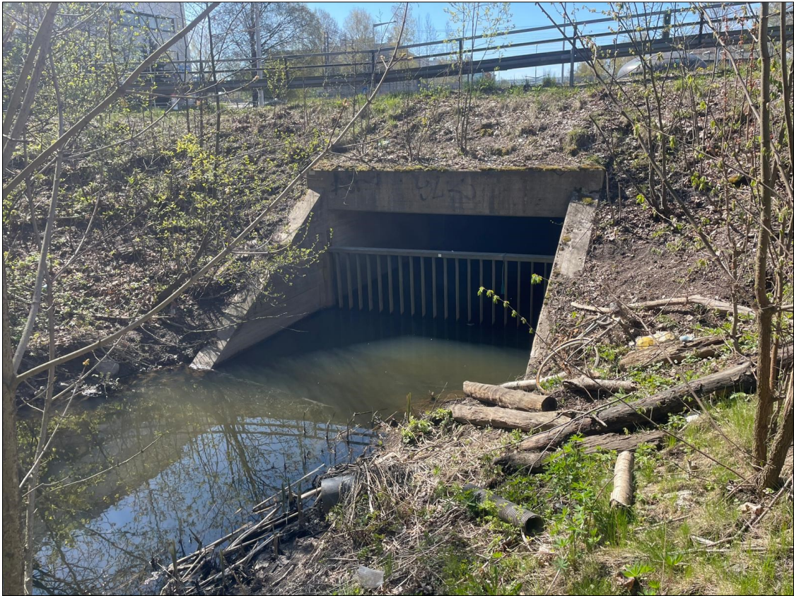
Kuva 21. Kaupintien ali menevän maanalaisen kanavan yläpäässä sijaitseva ritilä.
