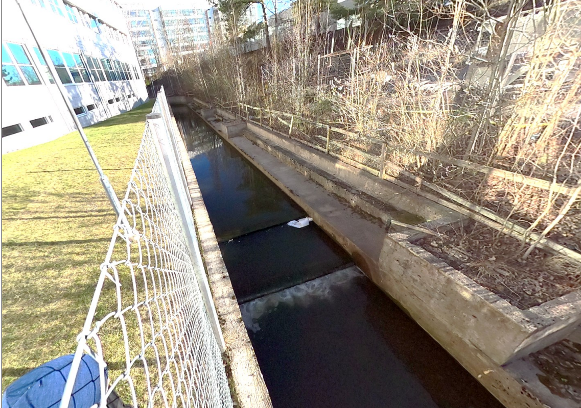
Kuva 19. Strömbergin puiston ylävirran puolella oleva kanava. Kanava kulkee Taitotalon ja ABB:n rakennusten välistä. Kanavassa sijaitsee pieni kynnyks.
