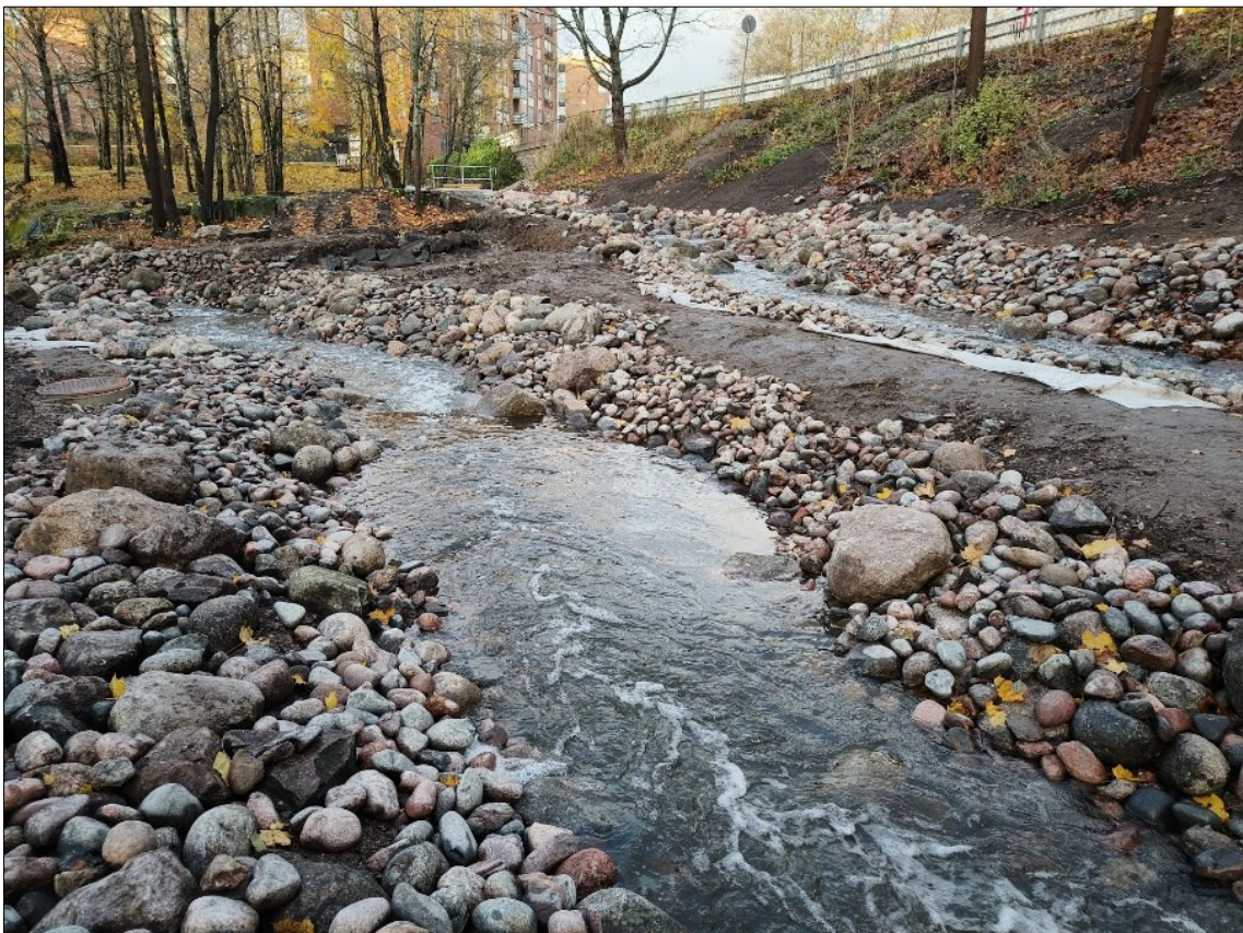
Kuva 18. Strömbergin puiston vastavalmistunut kalatie syksyllä 2025 (kuva: Giovanni Chaurand/Sitowise Oy). Vesiputous (Kuva 17), jonka kalatie kiertää, on kuvan vasemmassa reunassa.
