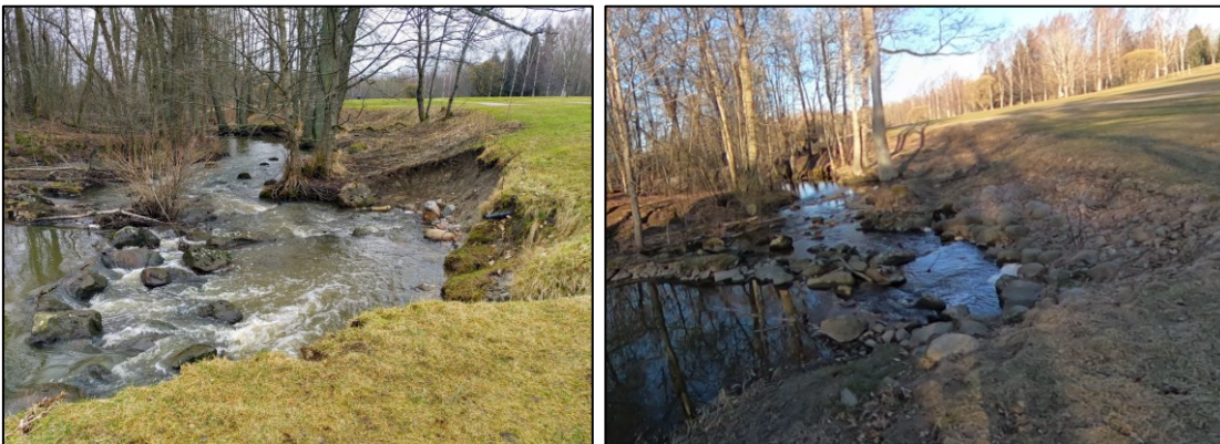
Kuva 15. Talin golfkentän alueella toteutettu padon ja uoman eroosio- ja kunnostus. Vasemmanpuoleisessa kuvassa uoma ennen toteutettuja toimia vuonna 2020 (kuva: Sitowise, 2020), ja oikealla uoma kunnostuksen jälkeen (kuva: Sitowise, 2025).
