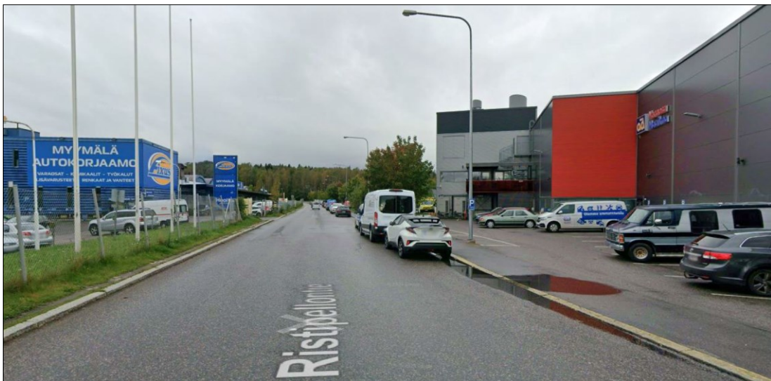
Kuva 58. Ristipellontien kadun tasaus muodostaa notkokohtaan, josta vesillä ei ole kunnollista tulvareittiä pois (kuva: Google Maps).
