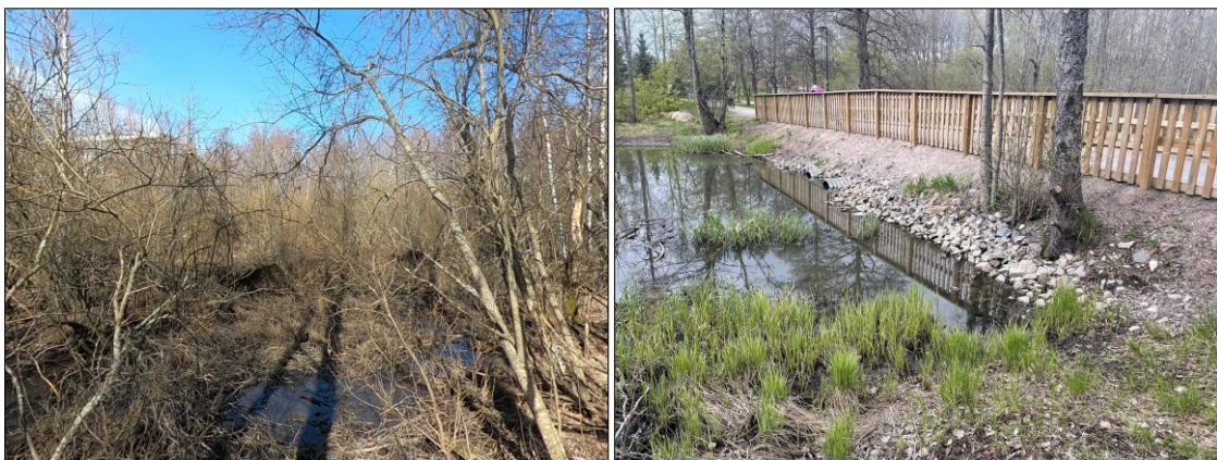
Kuva 35. Mätäojan yläjuoksu on paikoin voimakkaasti pajuttunut, ja joessa esiintyy useita lampimaisia osuuksia, jotka luontaisesti viivyttävät virtausta (vas.). Myrmyässä Haltiantielle johtavalla kävelytiellä puro alittaa reitin kahden rummun kautta (oik.).
