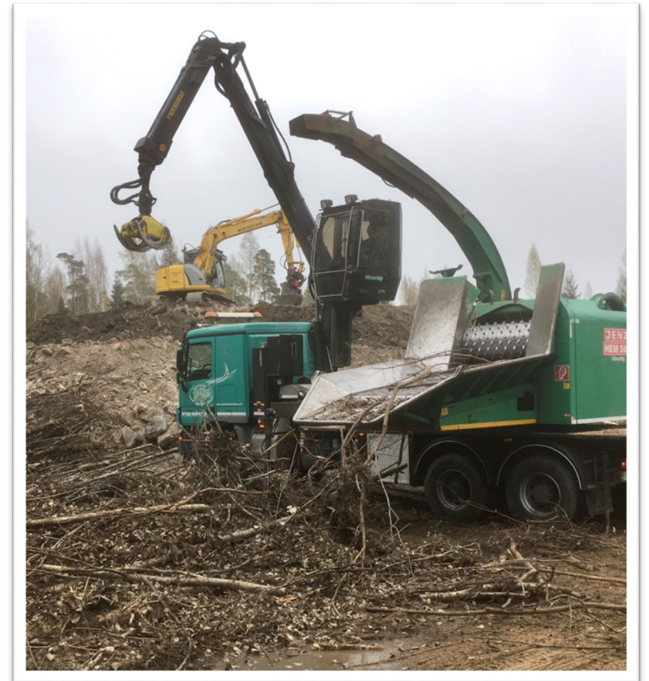
Kuva Kanervannummelta, Vantaalta. Suuremmille työmaille, joista syntyy paljon hakettavaa materiaalia, kannattaa haketus suorittaa isommalla hakkurilla / murskaimella.
