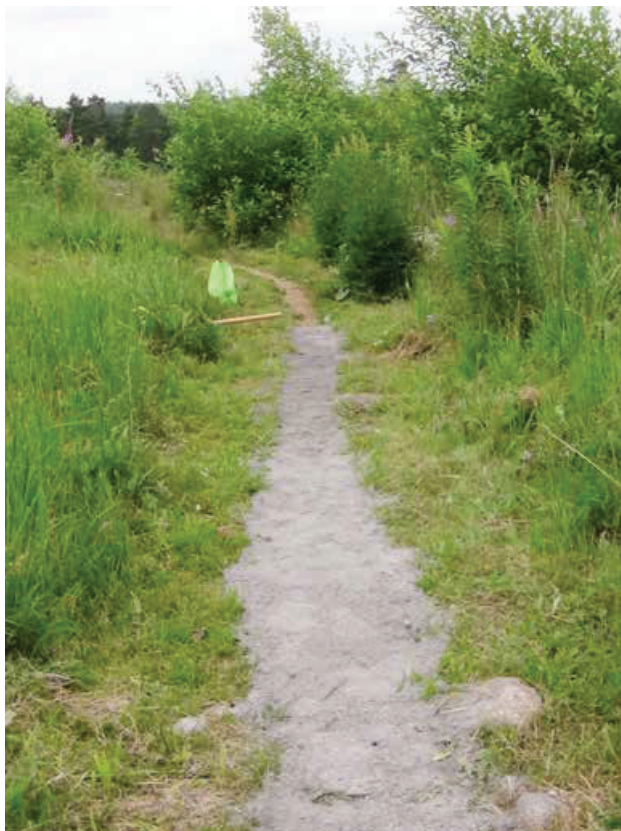
Kuva 47 Polkua on korjattu uudella karkealla maa-aineksella eroosiojälkien paikkaamiseksi. (Stara 2013)
