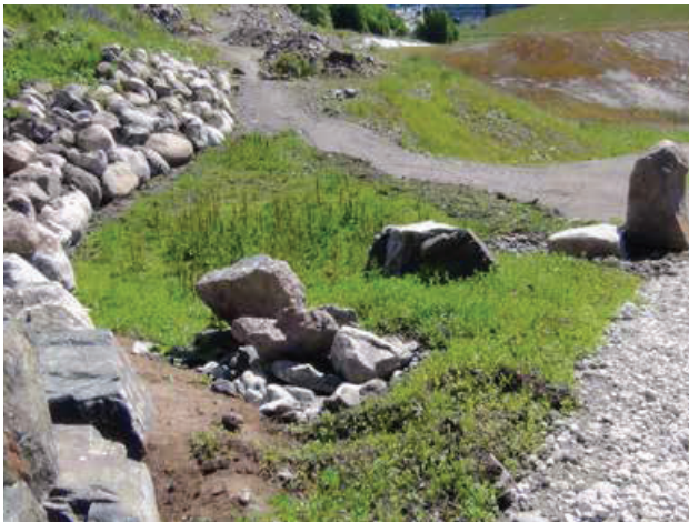
Kuva 42 Ympäristöluvan ehtojen mukaisesti luotiin hulevesiä keräävä painanne maantäyttöalueen eteläosaan. Painanteeseen siirrettiin hierakoita kasvavaa pintamaata lähialueelta. Myöhemmin osoittautui, ettei painanne pysy kosteana ja hierakat hävisivät. (Stara 2013)
