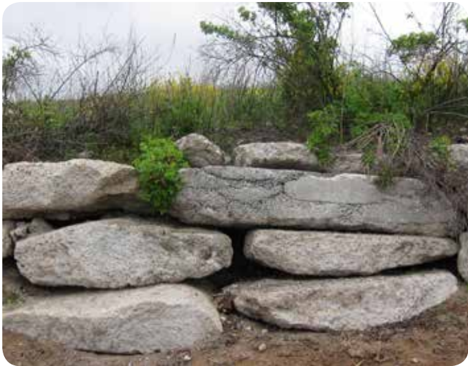
Kierrätysbetonista rakennettu muuri sijaitsee Eteläiseltä sisäänkäynniltä lähtevän polun varressa. (T.Tuominen)
