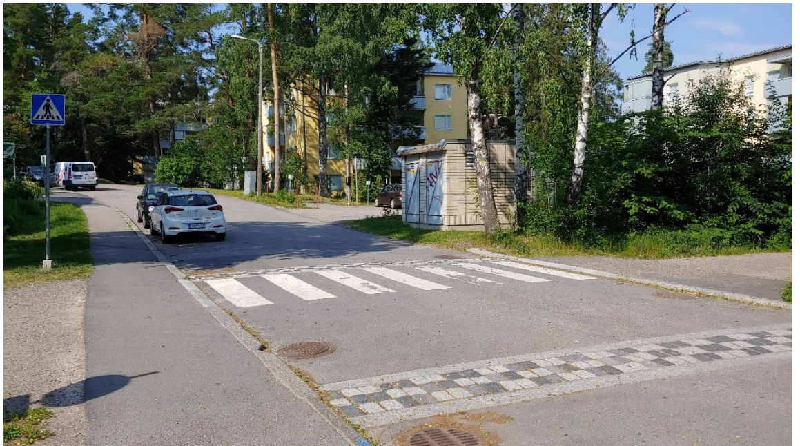
Kuva 7.11. Korotettu suojatie Aittatiellä.
