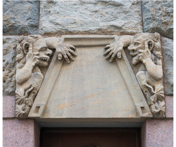
Kansalliseepos Kalevalasta nimensä saaneen ensimmäisen suomalaisen palovakuutusyhtiön Pohjolan toimitalon arkkitehtuurikilpailun ehtona oli, että katujulkisivut ovat suomalaista kiveä. Pohjolan talon julkisivuja hallitsee runsas luontoaiheinen ja kansallisromanttinen koristelu. Aleksanterinkatu 44. Matti Similä / Helsingin kaupunginmuseo
