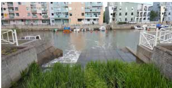
Kuva 18. Kalaporras ja patolaatta puretaan
