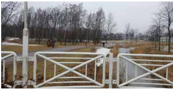
Kuva 31. Uusi ohitusuoma rakennetaan selkeästi matalampana erottuvaan kohtaan maastossa
