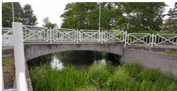
Kuva 19. Uoma ruopataan ja alajuoksulle rakennetaan tekokoski
