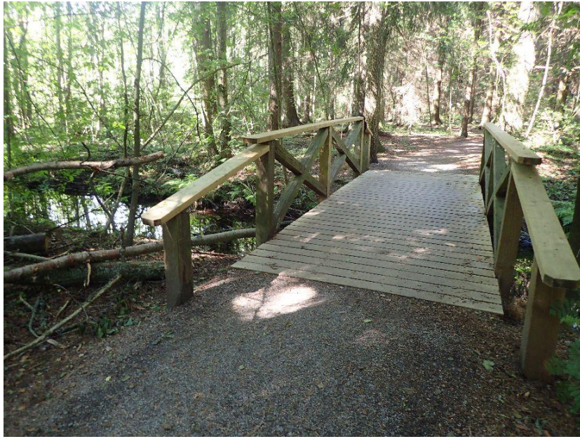
Kuva 30 Laskuojan ylittävä silta oli hyväkuntoinen vuonna 2020.
