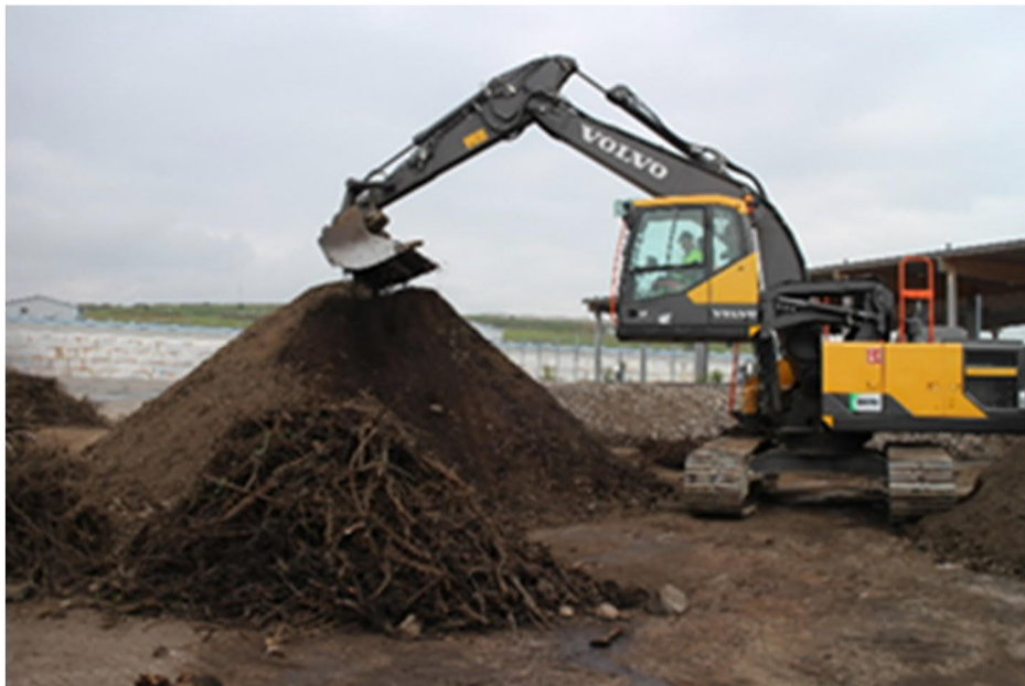
Kuva: Vieraskasvilajeja sisältävää maa-ainesta puhdistettiin välppäkauhalla. Koekasojen käsittelyn tuloksena vieraskasvilajien juurien ja oksien poisto onnistui. Kuvaaja Sari Jurmo.
