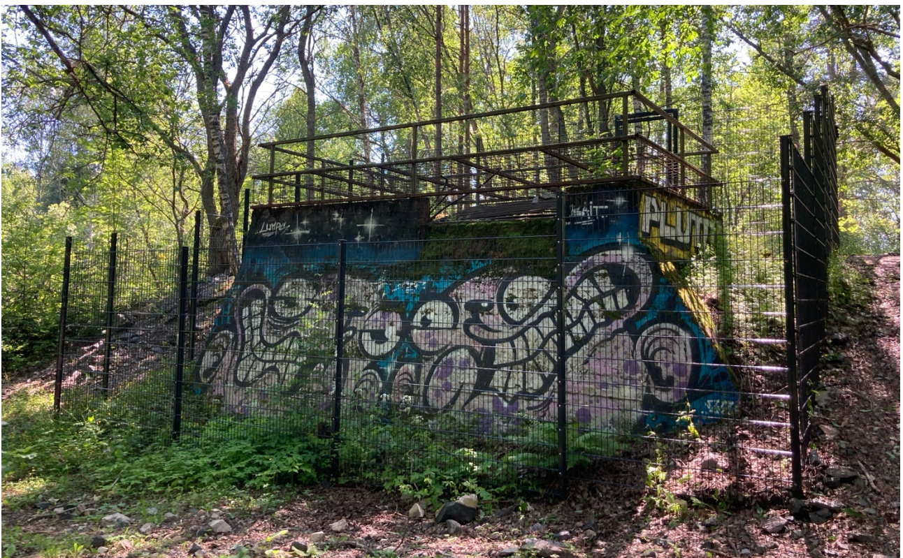
Kuva 19. Louhoksen kaivoskuilu on rakennettu 1950-luvulla ja se on noin 60 metriä syvä. Kuilu on aidattu turvallisuussyistä ja sen rakenteisiin on maalattu graffiteja.
