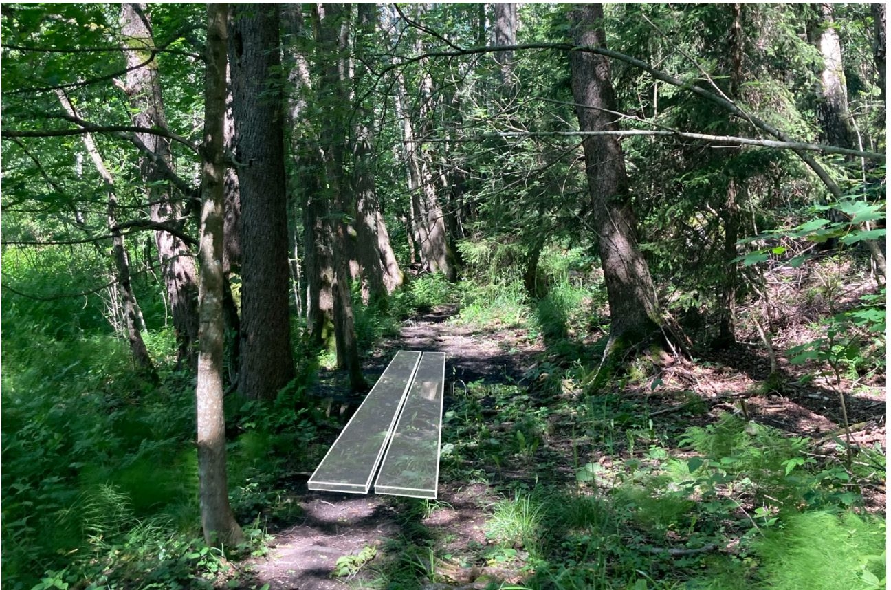
Kuva XX. Mellunmäen luhdan reunaan rakennetaan märkiin kohtiin kulkua helpottavia rakenteita, kuten pitkokset tai lankkupolku.
