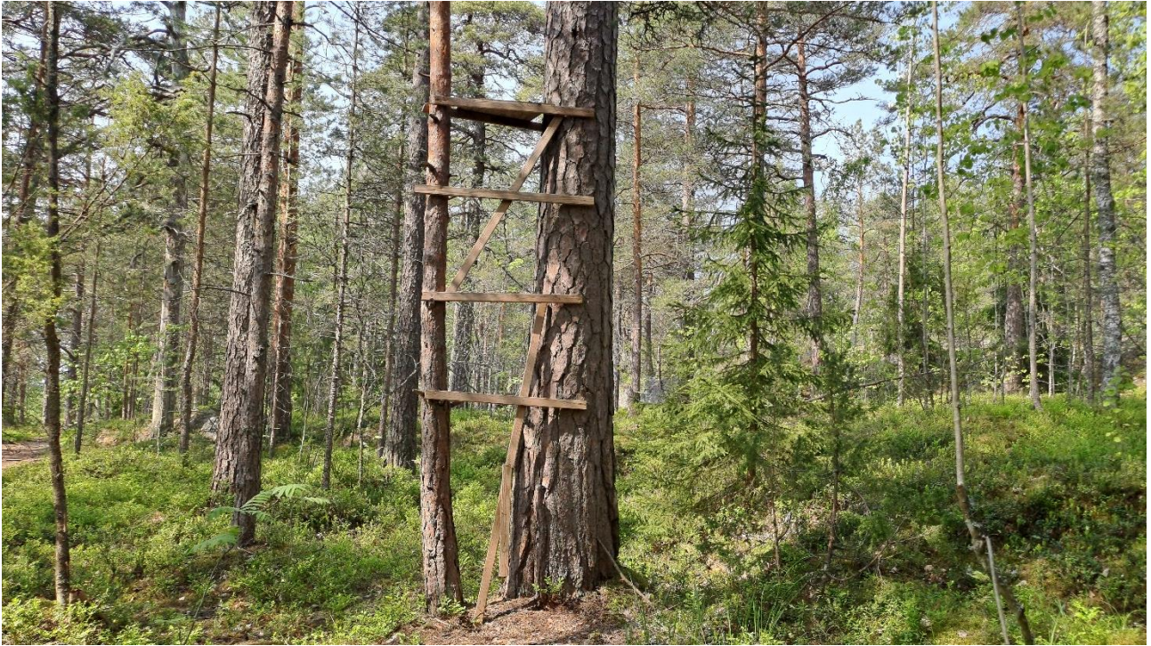
Kuva 3-2 Omatoimisesti rakennettu katselutasanne on kiinnitetty suoraan mäntyjen runkoihin.
