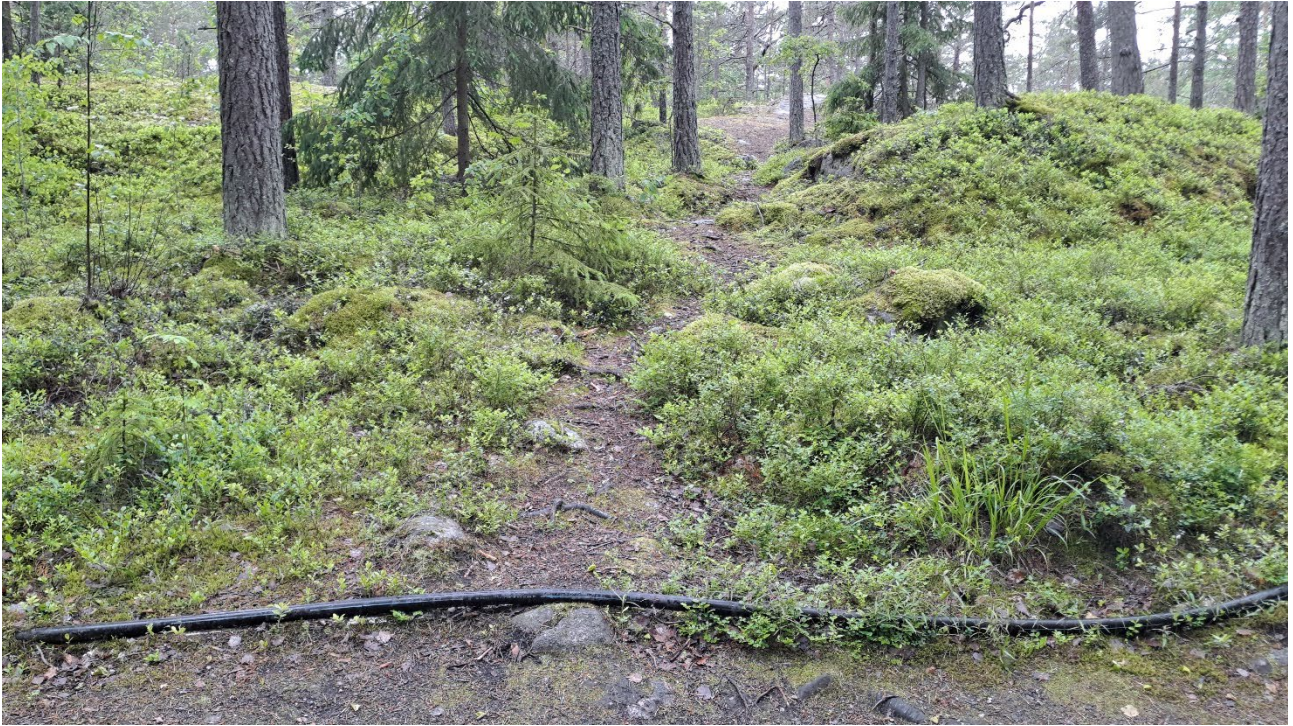
Kuva 3-14 Furuviikintien reunassa suunnittelualueen puolella kulkee kesävesijohto maanpinnalla.
