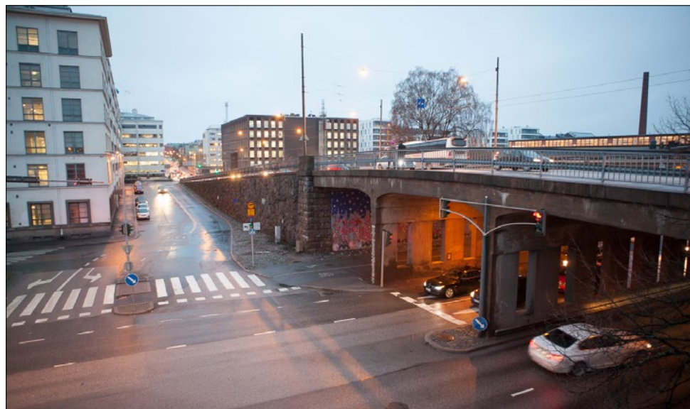
Sturenkadun silta, nykytilanne.
