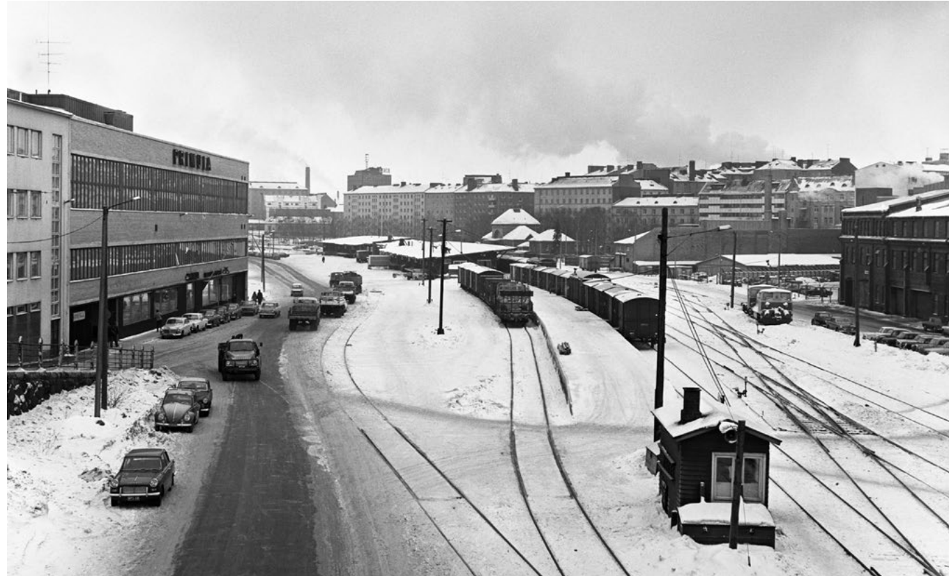
Näkymä Surenkadun sillalta itään 1968. Satamarata purettiin vuonna 1987 ja Vallilan tavara-asema vuonna 2001.
