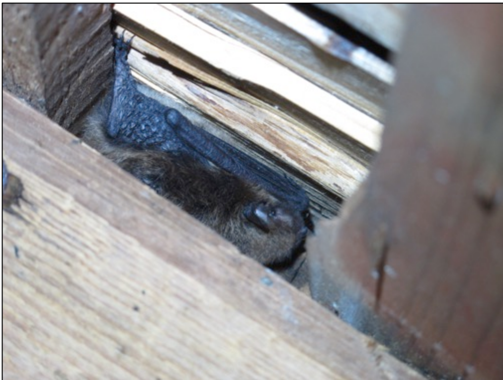
Liite 7. Aikuinen vesisiippa Iso liluodon Punaisen rakennuksen ullakolla.
