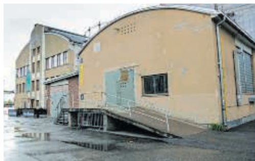
Tiivistämössä mitattiin ja tiivistettiin ennen kaasua. VIRPI PELTOLA
