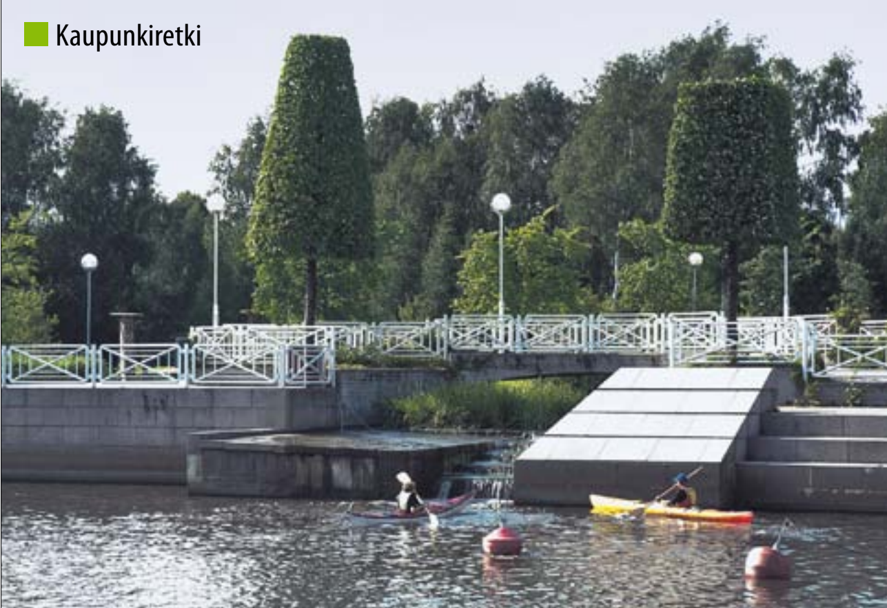
Pikku Huopalahdessa Mätäpuron suulle on rakennettu kalaportaat.
