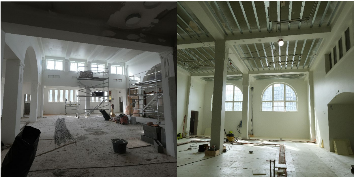
Työmaakuvia Hakaniemen kauppahallin tulevan ravintolan tiloista
