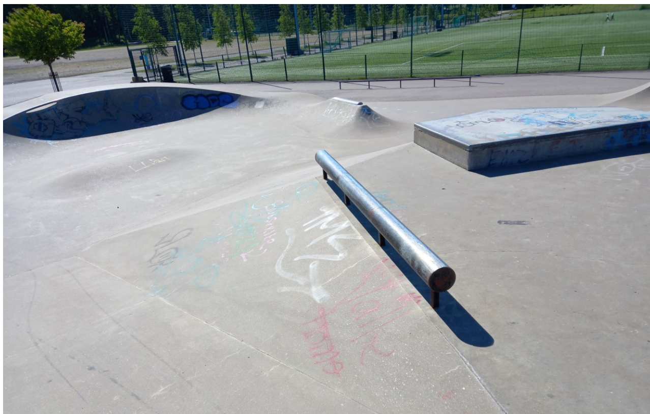
Kuva 6. Skeittipaikkojen betonielementteihin yhdistetään usein skeitattavuusominaisuuksien vuoksimetallia ja luonnonkiveä.
