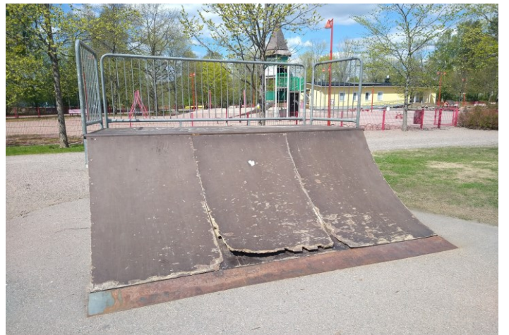
Kuva 12. Rakennusmateriaalina vaneri kestää huonosti suomen sääolosuhteita.
