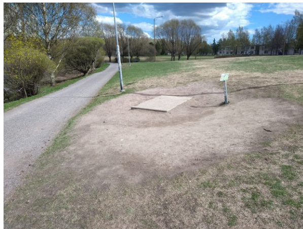
Kuva 6. Siltamäen frisbeegolfradalle on toteutettu noin 1,5x2,4 m kokoiset betoniset heitto- alustat, jotka on käytössä osoittautuneet liian pieniksi.
