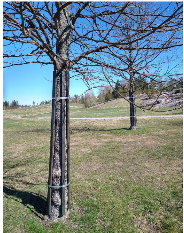
Kuva 17. Puiden runkovaurioiden suojausta laudoituksella Kivikon frisbeegolfradan puisto-osuudella.
