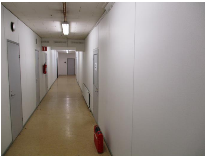
kuva 5. 2. kerroksen "toimistokäytävä" materiaaleissa ei havaittu asbestia. lattialla muovimatto ja seinissä kipsi- ja lastulevyä.
