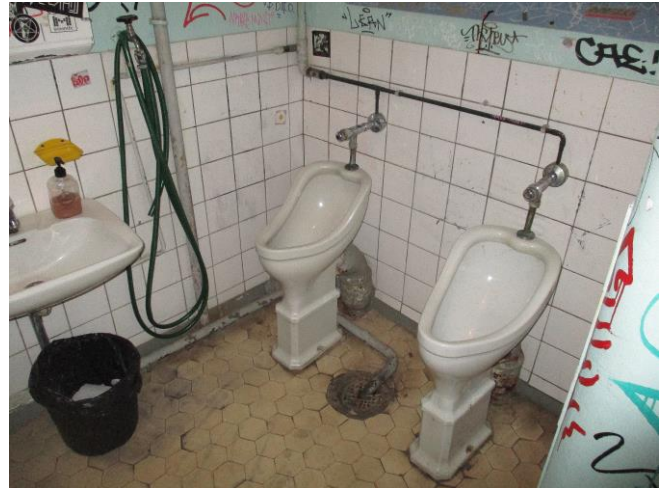
kuva 2. Pintabetonilaatan alla oleva vedeneriste oli PAH-pitoinen. Seinälaatoitukset olivat niin uusia- ja vastaavasti lattialaatoitukset niin vanhoja, etteivät sisällä asbestia.
