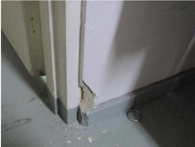
kuva 3. Näyte 6. asbestikuitulevyä.
