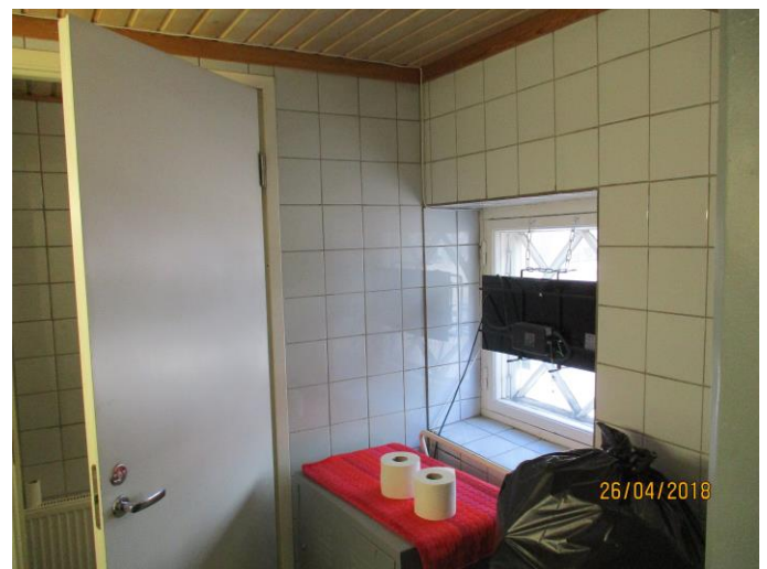
kuva 6. Uudempia asbestittomia laatoituksia oli monin paikoin.
