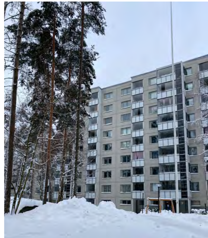
Näkymä lamellikerrostalojen väliseltä pihalta.
