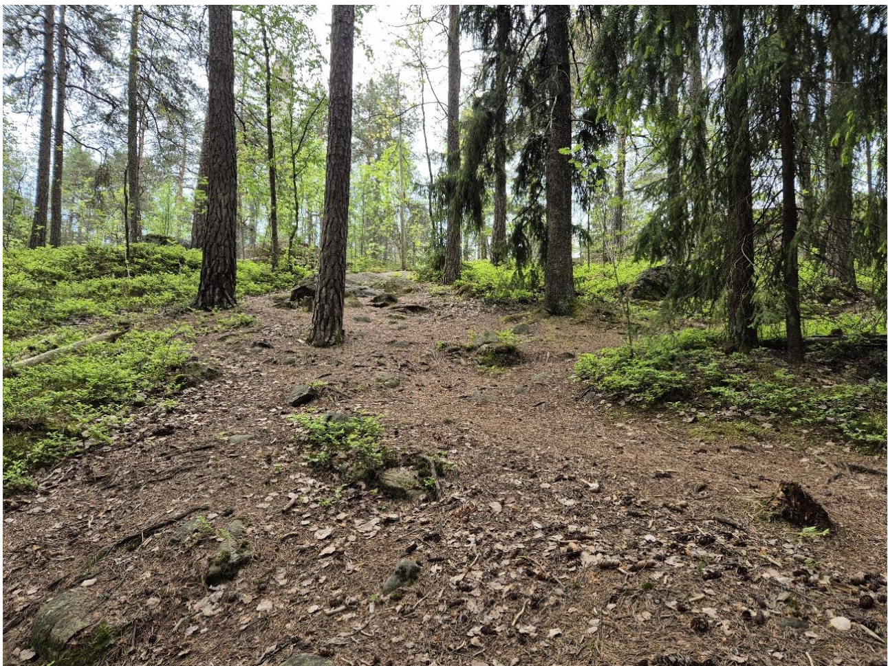
Kuva 6-1. Suunniteltu kaiteellisten portaiden sijaintipaikka. Kasvillisuus on kulunut hyvin laajalta alueelta ja rinne on erittäin altis eroosiolle tehden reitistä entistä vaikeakulkuisemman.
