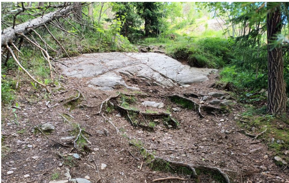
Kuva 6-1. Virkistyskäytön suunnitelmassa ehdotetaan portaita alueen pohjoisosan länsi-itäsuuntaiselle merkitylle polulle, koska polku on runsaasti käytetty, mutta jyrkkä ja epätasainen, ja siinä on voimakasta eroosiota.
