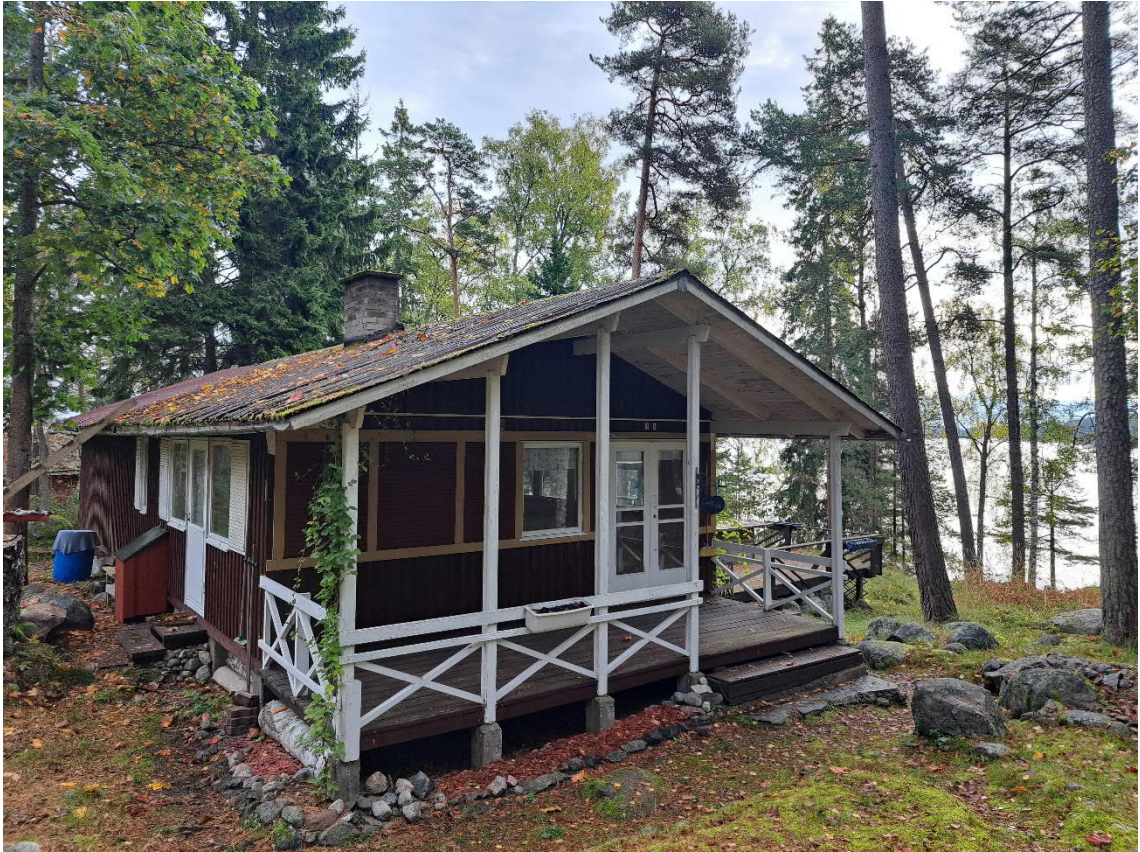
Kuva 3 Alueen olemassa oleva rakennus
