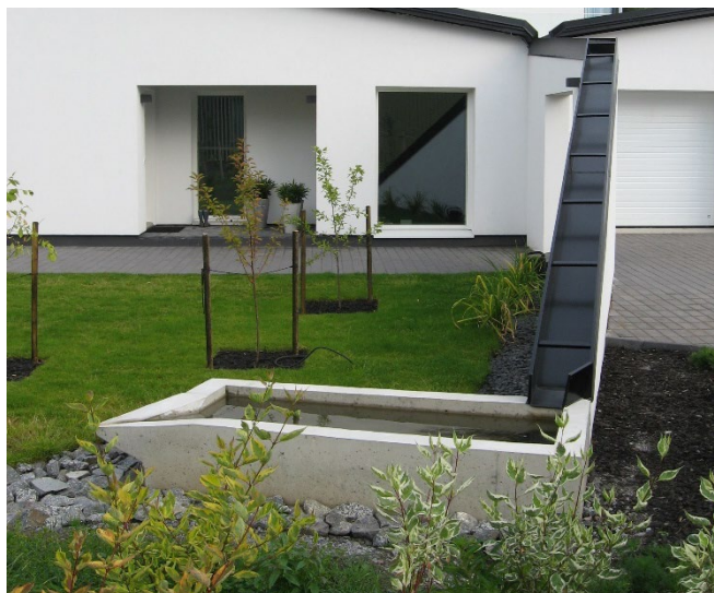
Kuva 7. Hulevesiin kannattaa suhtautua hyötynä, ei haittana. Kattovesien hyödyntäminen puutarhan kasteluun on erittäin järkevää. Kuva Tampereen Vuoreksen asuntoalueelta, jossa pientalon katolla muodostuva hulevesi on johdettu modernilla ja innovatiivisella tavalla pieneen vesialtaaseen. Vastaava perinteinen ratkaisu olisi vesisaavi syöksytorven alla.
