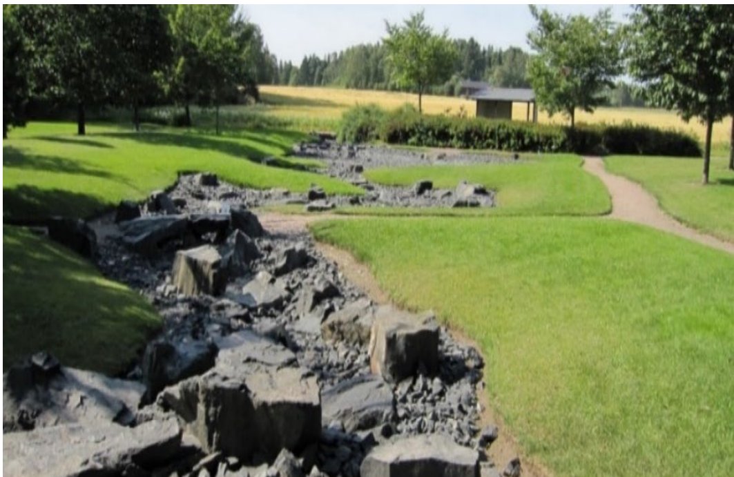
Kuva 1. Hulevesien viivytyksrakenne Eko-Viikissä.
