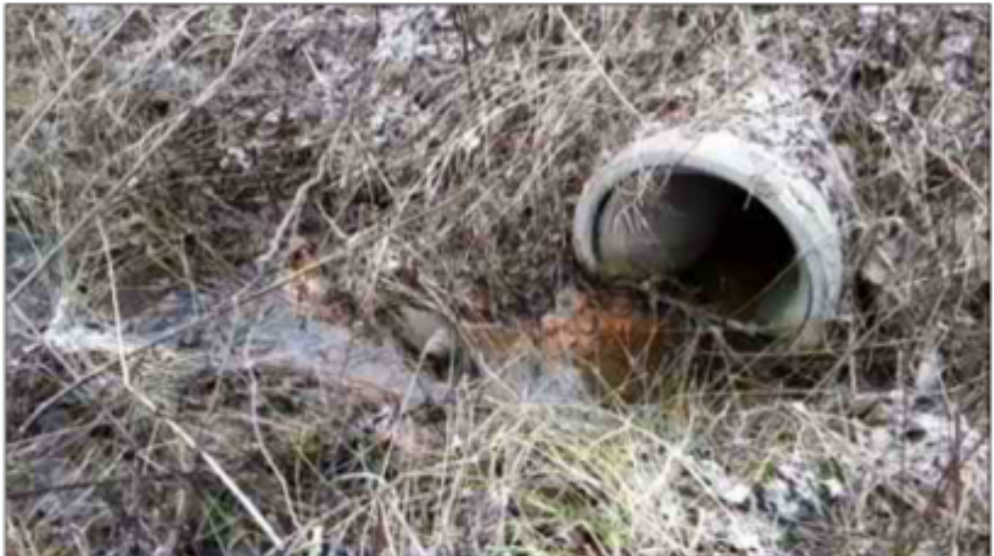
Kuva 10. Viilarintien 1000B viemäriin liittyvän 500B viemärin suu
