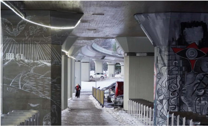
Metroaseman ovilta aukeaa pitkä kaartuva näkymä metrosillan alle.
