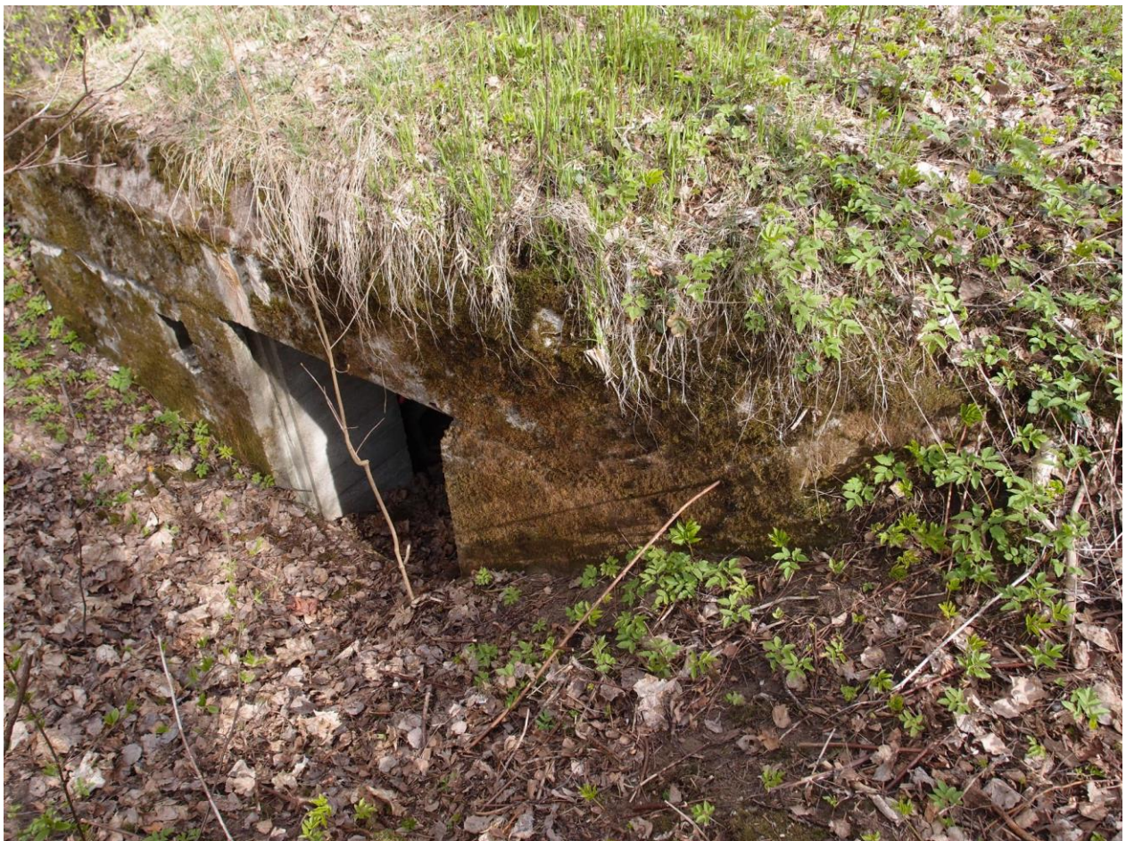
Puolustusasema IX:6:n suojahuone.
