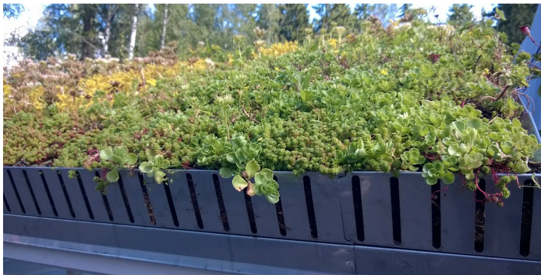
Kuva 9. Viherkattoa voidaan käyttää hulevesien viivytyjärjestelmän osana, jos sen kasvualusta on riittävän paksu. Kasvualustan paksuudella on vaikutusta myös kasvillisuuden menestymiseen, sillä liian ohuessa kasvialustassa jopa kuivuuteen sopeutuneet kasvit saattavat kuivua paahteessa kokonaan pystymättä enää uusiutumaan.
