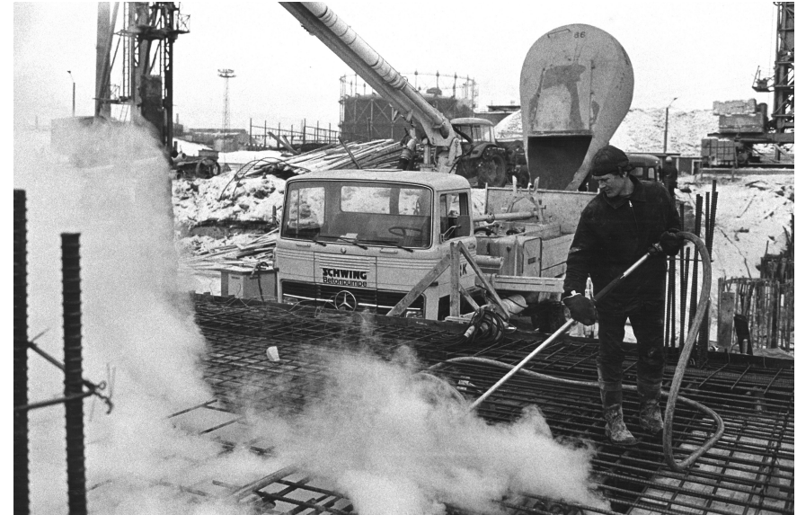
Välipohjan talvibetonityö 1972. Kuva Helenin arkisto.
