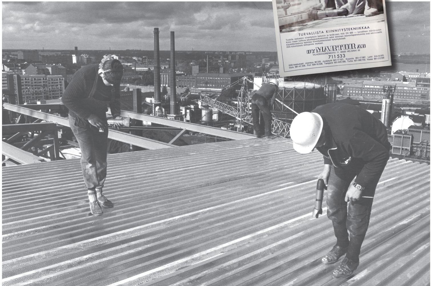
Poimupeltilevyjen asennusta kattilahallin katolla, noin 55 metrin korkeudella, vuonna 1973. Helenin arkisto. (Rakennustyön turva- määräykset ovat sittem- min tiukentuneet)
