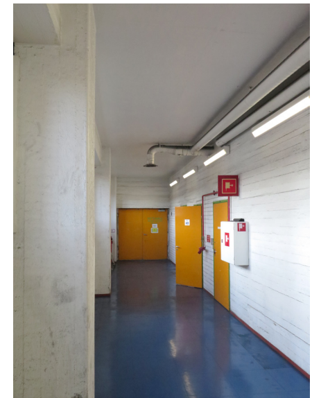
Blokkien 3-4 välinen henkilöliikennekäytävä / aputila kokonaisuus.
