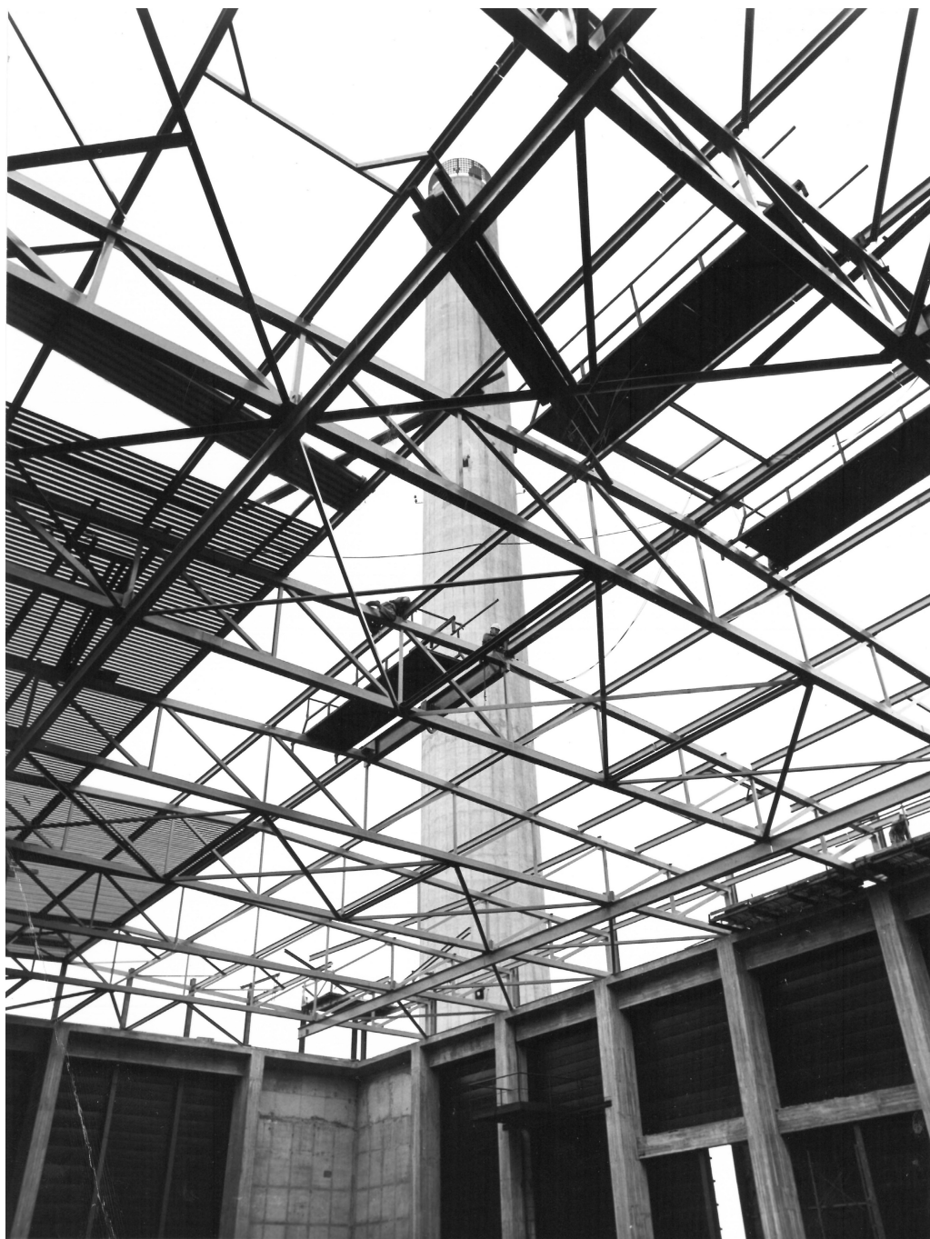
Kattilahallin teräsristikot asennettuna ja niiden päälle kiinnitetyt I-palkit pääosin paikoillaan. Vasemmalla näkyy poimulevyn asennusta; huomaa levyjen perforoinnista aiheutuva läpinäkyvyys. 6/1974, Kuva: Helenin arkisto
