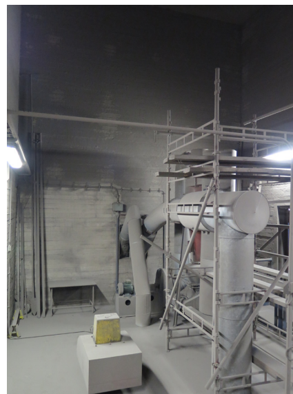
Lentotuhkatornin yläosa, hiilikuljettimen alapuolella.
