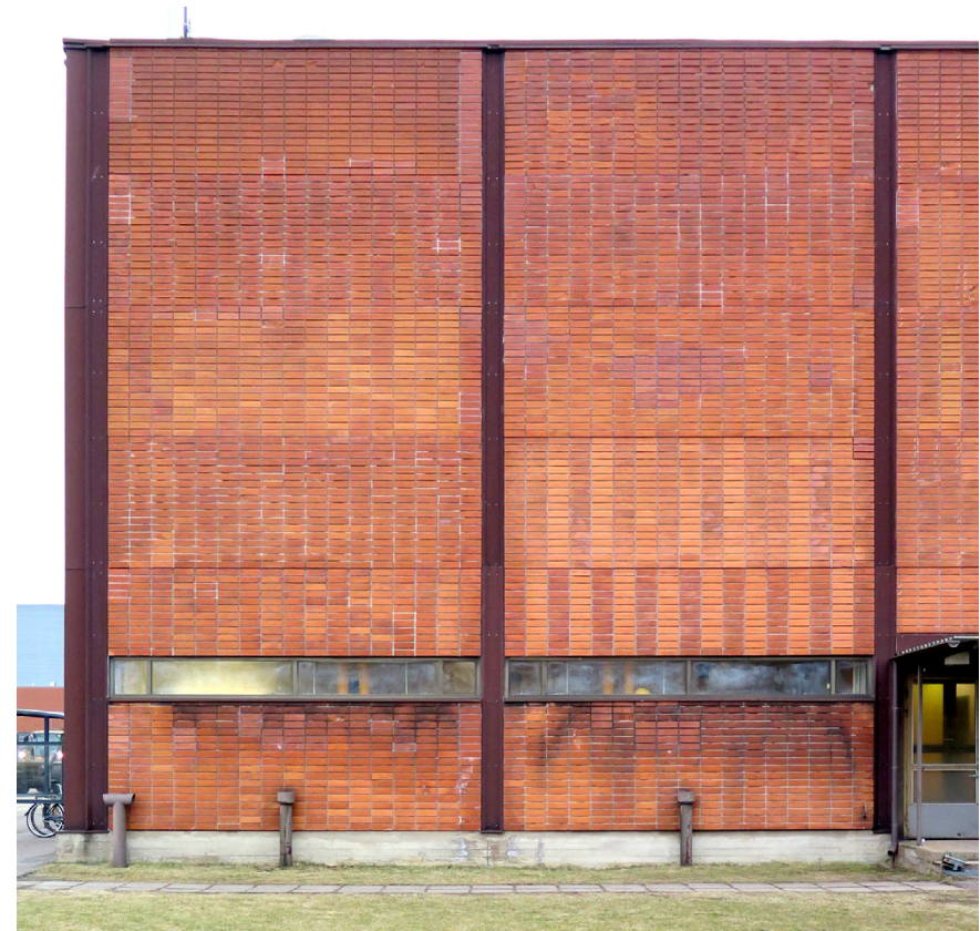
Elementtien alkuperäiset tiililadonnat muodostavat polttoasteen mukaan elävää ja kertovaa vaihtelevuutta, jota toisaalta tuskin on suoranaisesti tavoiteltu. Tiilen sävyvaihtelut ovat kuitenkin leimallinen ja luonteikas osa voimalan olemusta, jota tulee myös jatkossa vaalia (tasavärisyyden sijaan).
