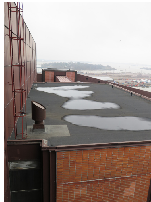
Esimerkki vesikatteesta hiilimyllytornin 3 kohdalla. Havaintojen perusteella katoilla ei (nykyisin) ole granoliittikerrosta.
