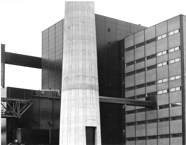
Rannan puolella, rakennuksen ydinalueella oleva porras-hissi-aputilat-torni on ulkonäöltään pari toimisto-tornille, mutta sisältää vain kapean sivukäytävän, WC-tiloja, hissit ja porrashuoneen. Kuva: 1974, Helenin arkisto.
