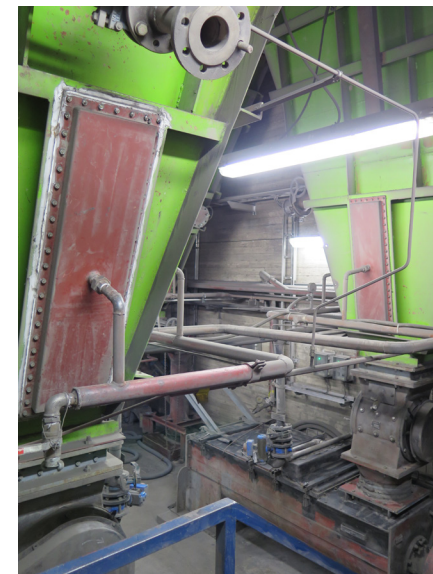
Lentotuhkasiilon alaosan kojeikkoja
