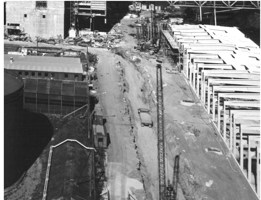
Rakennusvaiheessa otetussa kuvassa hallin elementtirunko näkyy luurankona. Helenin arkisto
