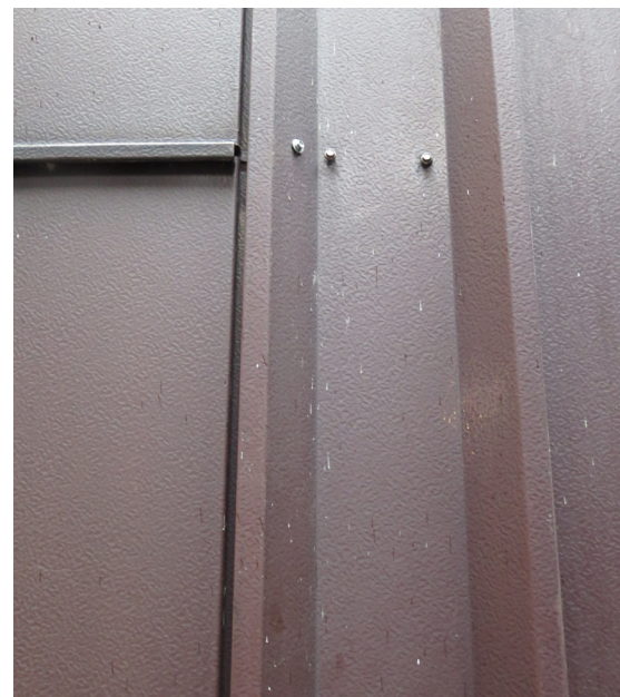
Robertson-versacor PVD-pinnoitettua peltiä. Alla tuntemattomasta syystä muodostunut vauriokohta, jonka alta paljastuu ehjä galvanointi.
