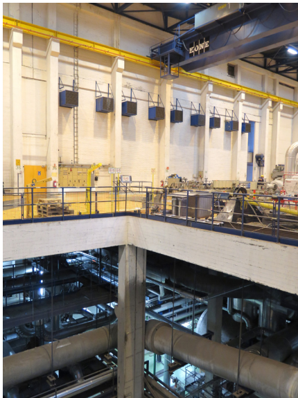
Huoltoaukko turbiinihallin välipohjassa (+14,50)
