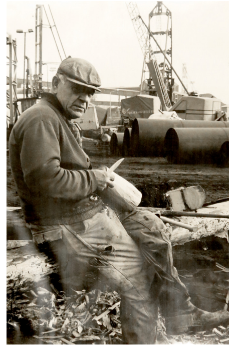
Kaksi rakentamisen aikakautta kohtasivat Hansaari B:n työmaalla 5/1971: kirvesmies Kalle Pöllänen perinteisine käsityökaluineen ja taustalla näkyvät junttakoneet erikokoisine kaivinpaaluineen. Kuva Helenin arkisto
