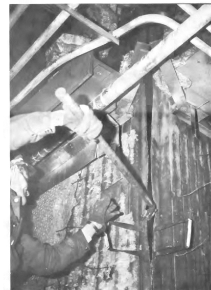
● Hana kolmesta koekäytettävässä kattilan nurkka repesi neljästi. Kukaan ei loukkaantunut, mutta riesaa riitti. Kuva on kesäkuun kuudennelta 1974.
