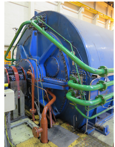
Turbiinin generaattorin siniseksi maalattu staattori ja vihreäksi maalatut vetyjäähdytysputket.
