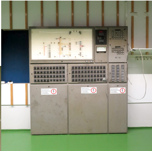
Ilmanvaihdon automaatiolaitteen seurantataulu, jossa vasemmalla turbiinihalli ja oikealla kattilahalli.
