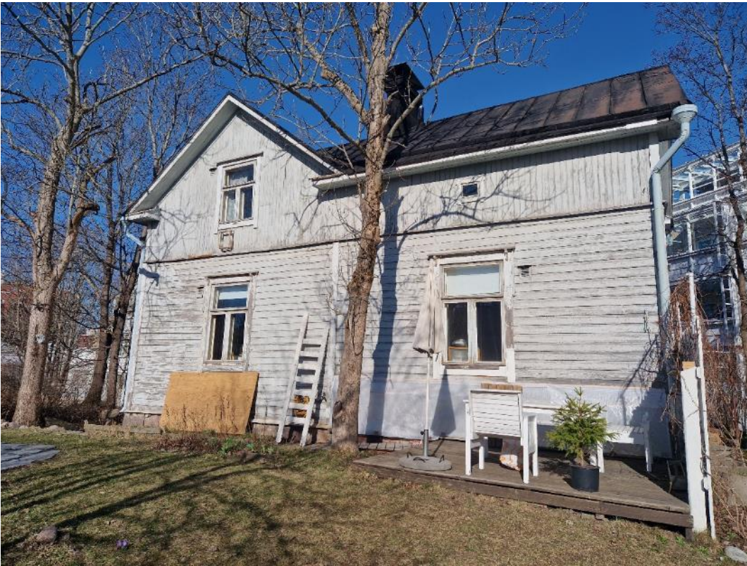
Kuva 5. Rakennuksen julkisivua kaakkoon.
