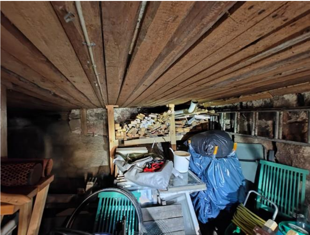
Kuva 19. Varastotilaa rakennuksen luoteispäädyssä.
