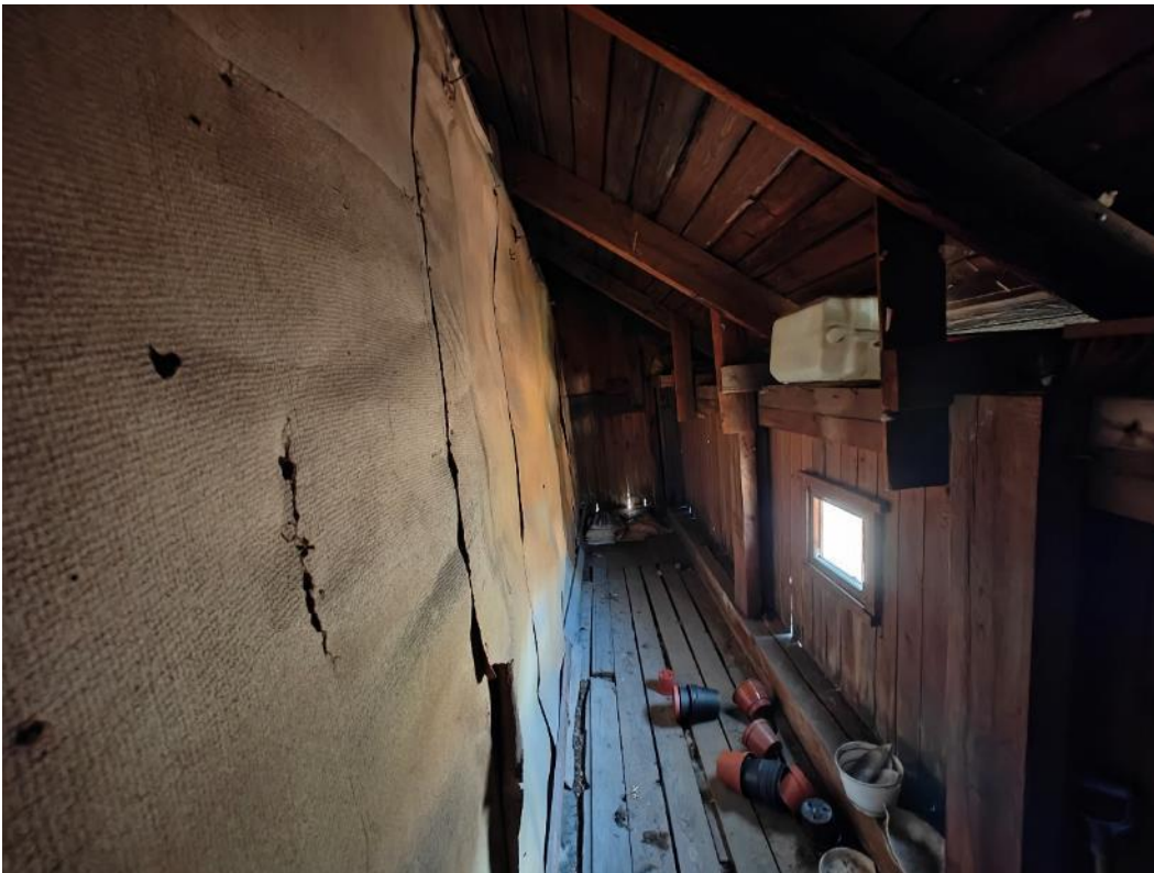
Kuva 50. Huonetilojen keskellä olevan ullakkotilan sivu-ullakkoa.
