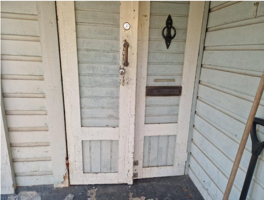
Kuva 37. Ulko-ovi on umpipuuovi, maalipinta on kulunut ja paikoin lohkeillut.
