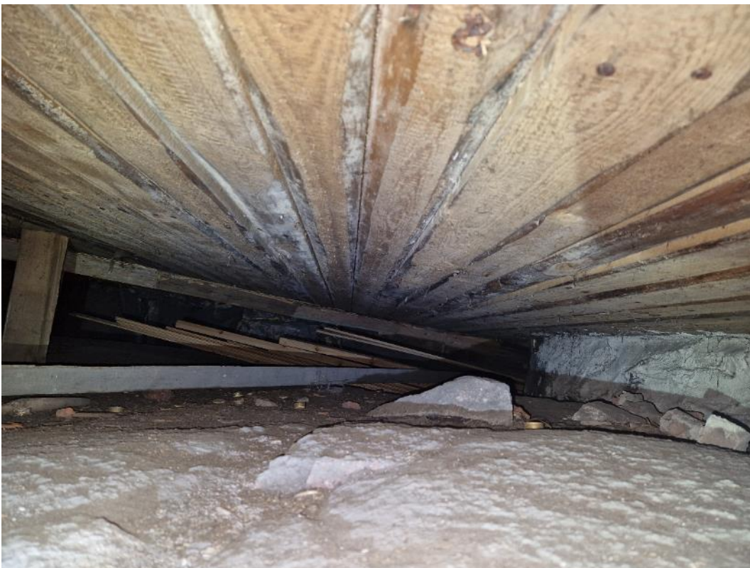
Kuva 24. Ryömintätilaa. Ryömintätila on paikoin hyvin matalaa. Ryömintätilassa havaittiin puutavaraa.
