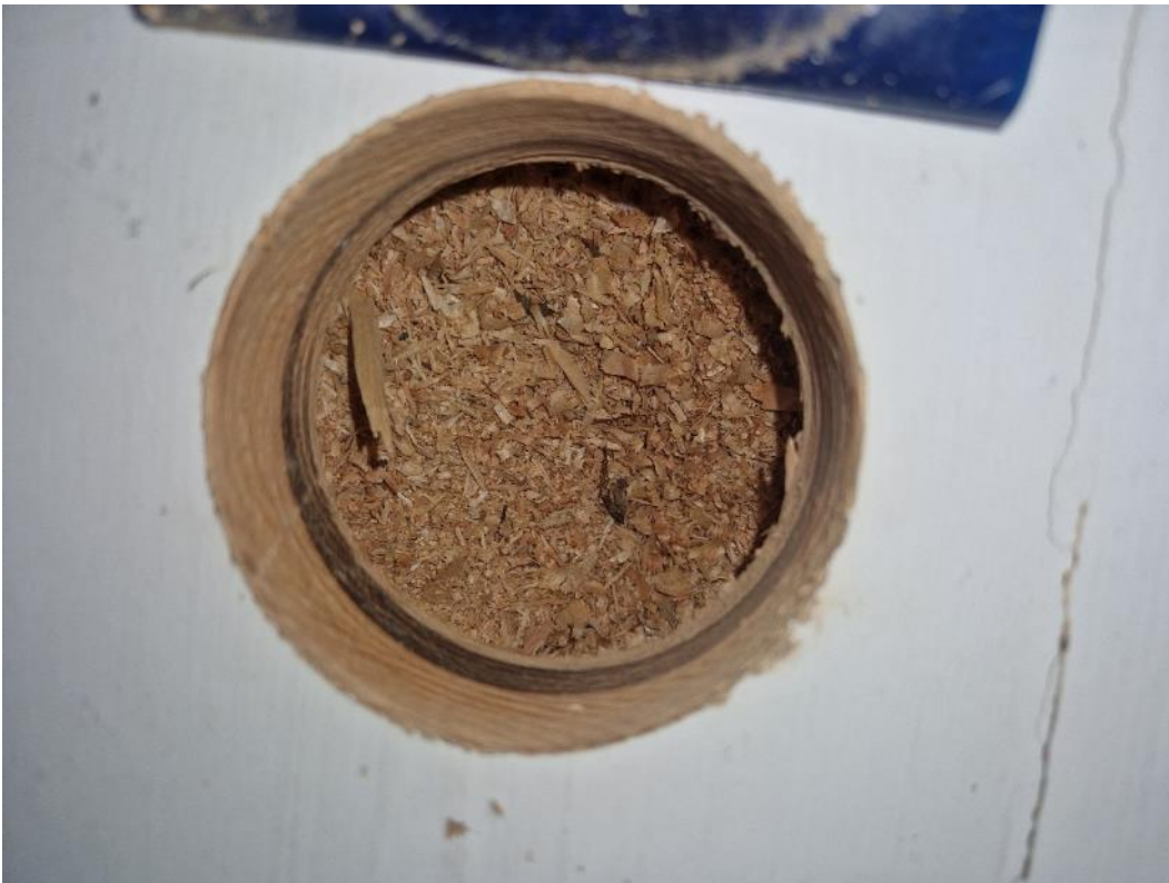
Kuva 32. Alapohjarakennetta koillispäädyn huonetilan kohdalla
