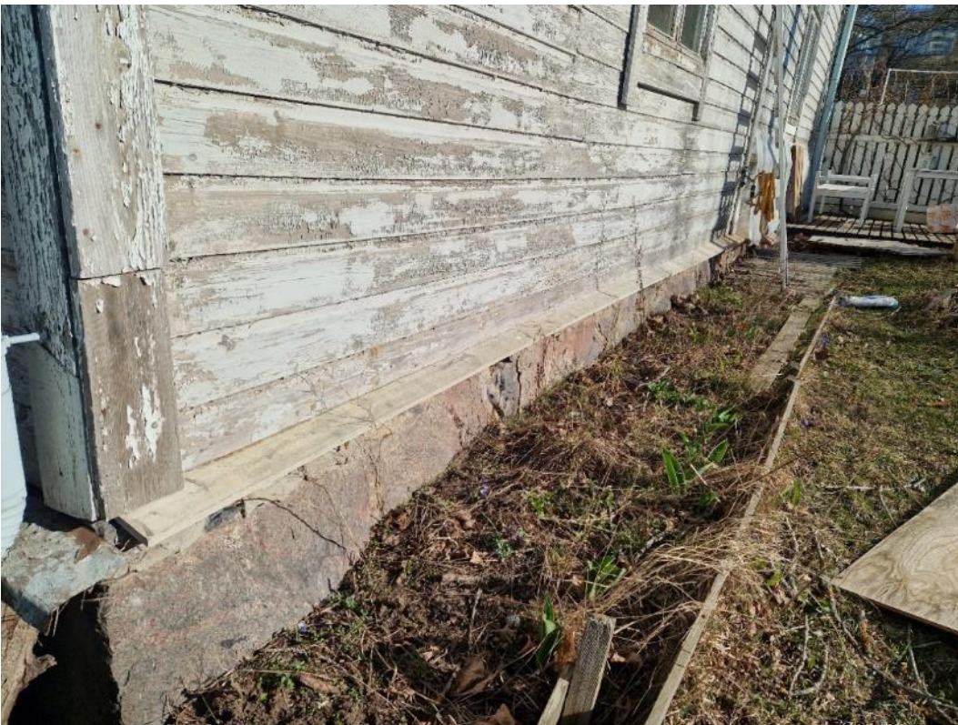
Kuva 12. Rakennuksen vierustaa kaakkoissivulla, sokkeli on luonnonkiveä.
