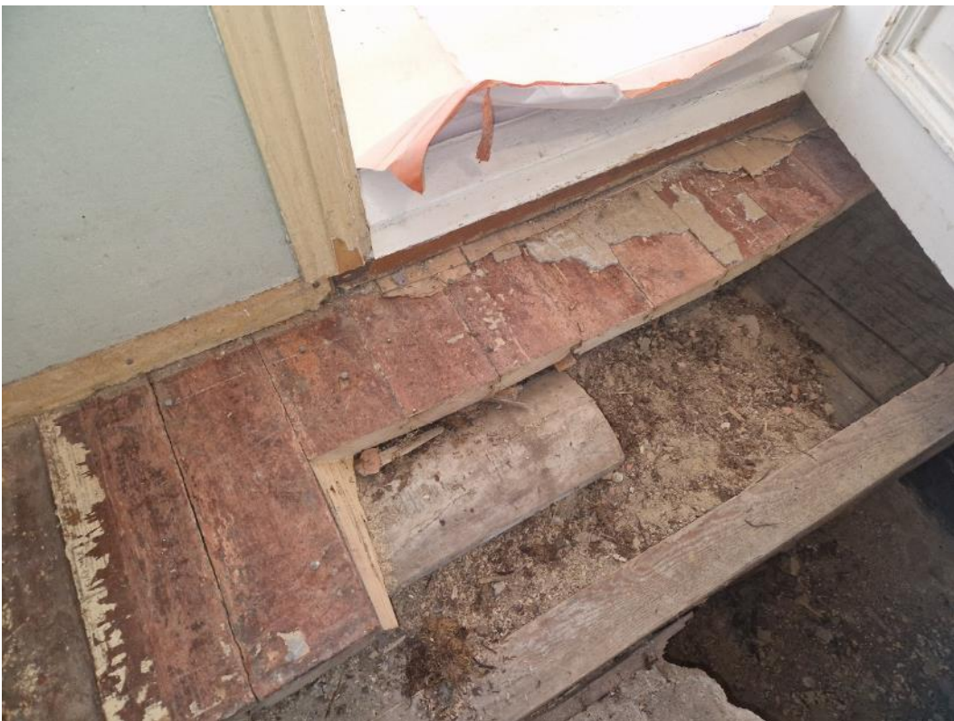
Kuva 30. Alapohjarakenteita eteisen / pesuhuonetilan kohdalla.
