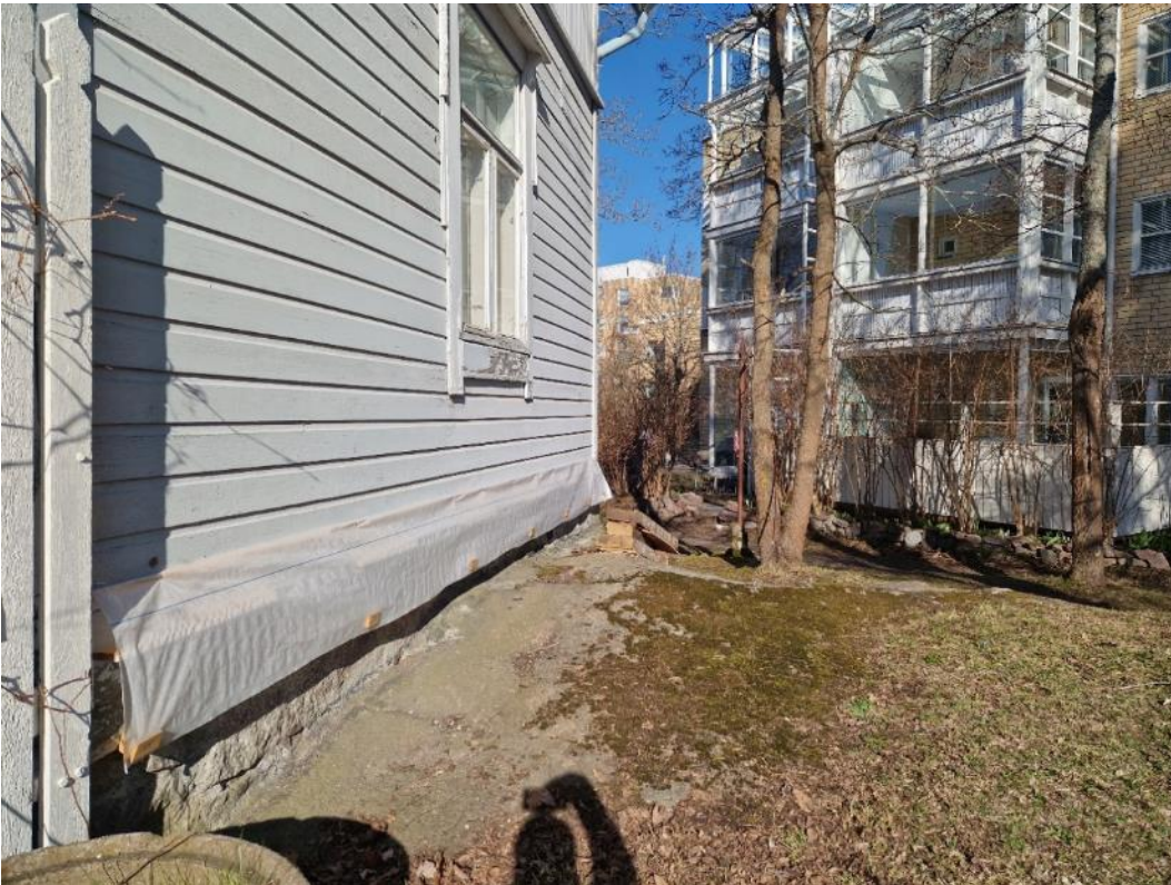
Kuva 11. Rakennuksen vierustaa koillissivulla. Rakennuksen vierustalla on näkyvissä kallio. Ulkoseinän alaosaa on suojattu sääräsitukselta ja kosteudelta.
