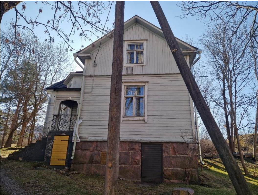
Kuva 2. Rakennuksen julkisivua luoteeseen.
