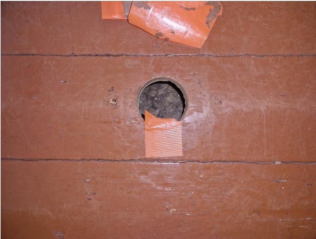
Kuva 31. Alapohjarakennetta toimistohuoneen (luoteispääty) kohdalla.
