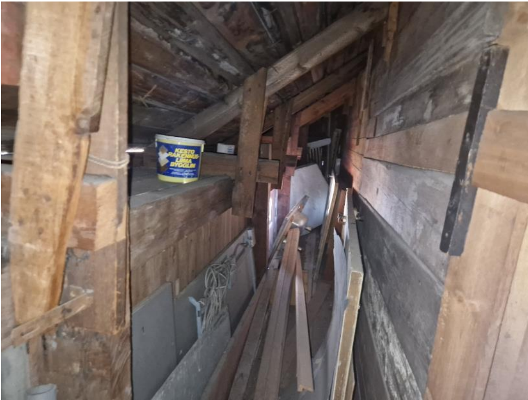
Kuva 49. Huonetilojen keskellä olevan ullakkotilan sivu-ullakkoa.
