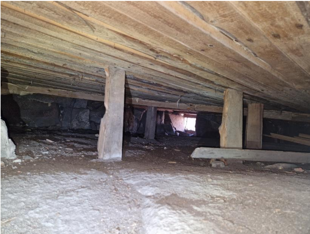
Kuva 23. Ryömintätilaa. Alapohjan tukipuut lähtevät kalliopinnan / maapohjan päältä.
