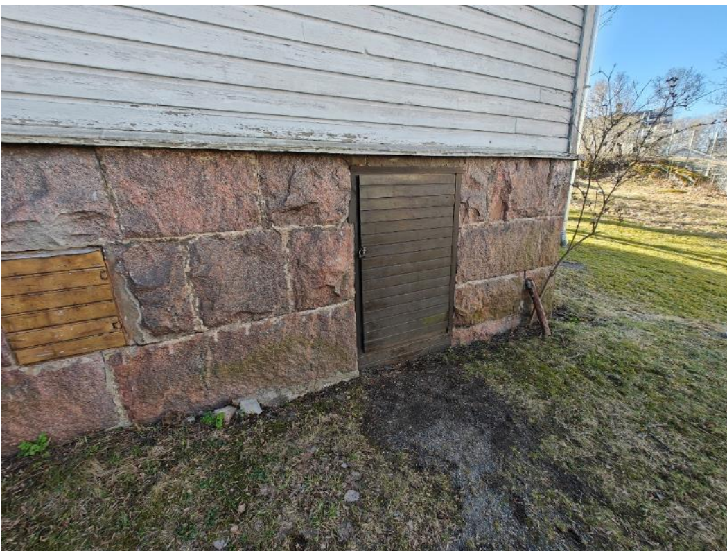
Kuva 38. Alustilan varaston ulko-ovi.
