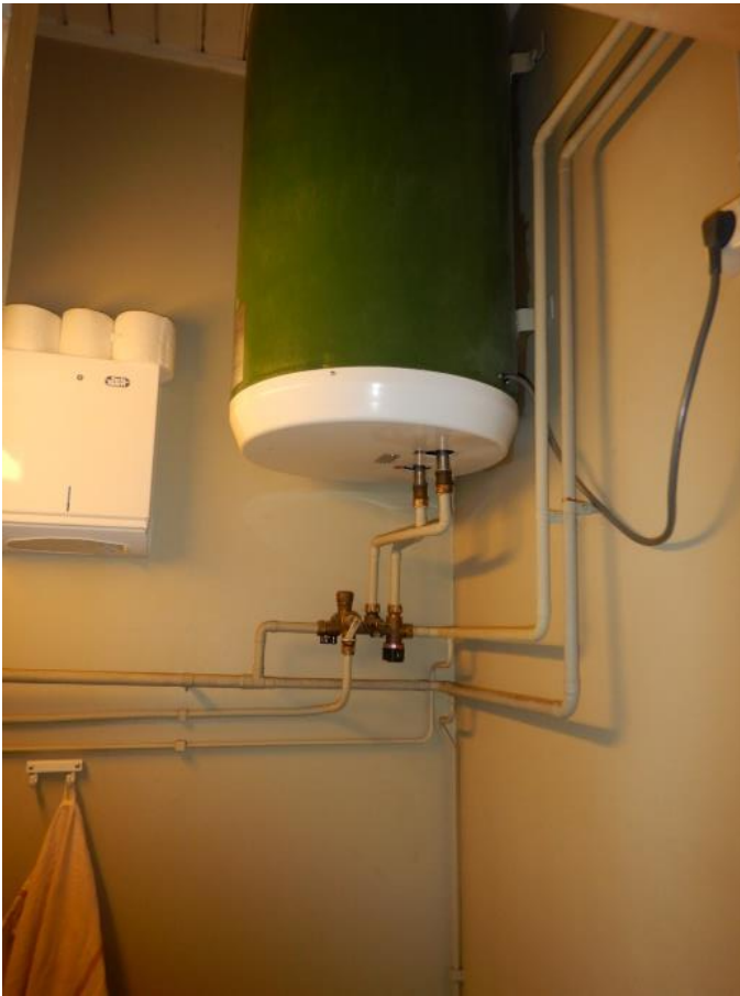
Kuva 69. Yleiskuva lämminvesivaraajasta.
