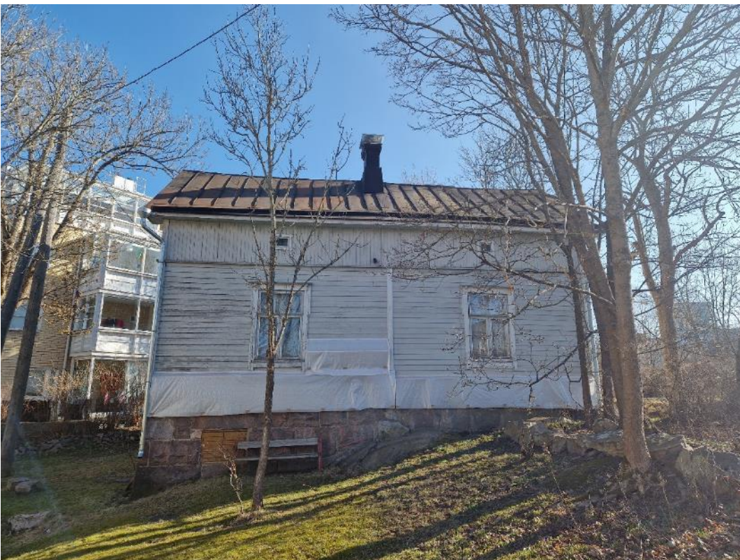
Kuva 6. Rakennuksen julkisivua lounaaseen.
