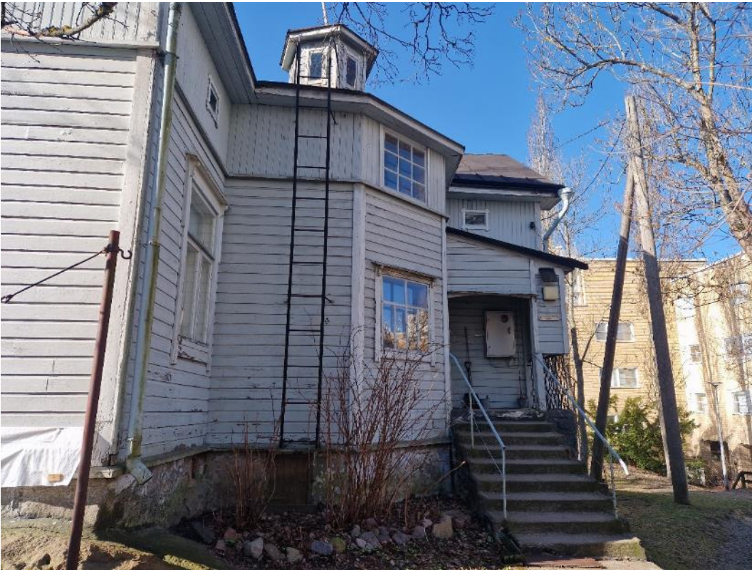
Kuva 3. Rakennuksen sisäänkäyntisivua (koillissivu).
