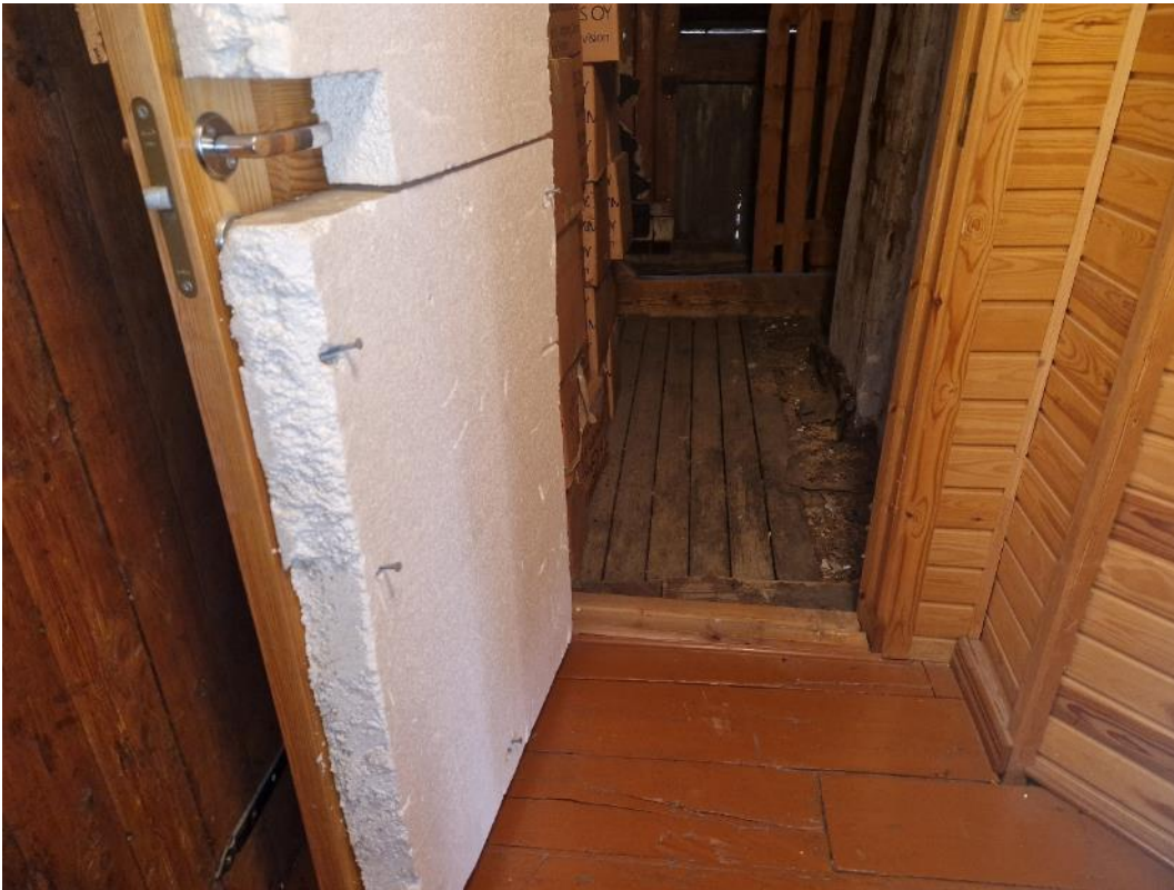
Kuva 47. Ullakkotilaa 2. kerroksen huonetilojen keskellä.
