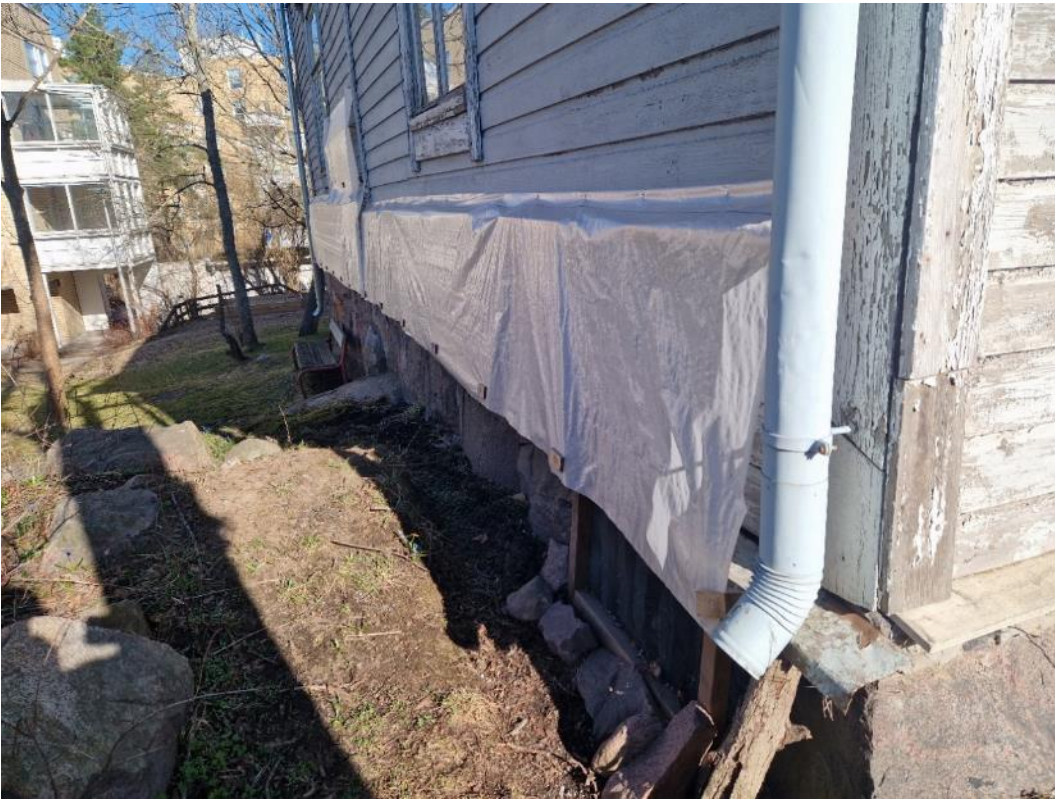
Kuva 13. Rakennuksen vierustaa lounaissivulla.
