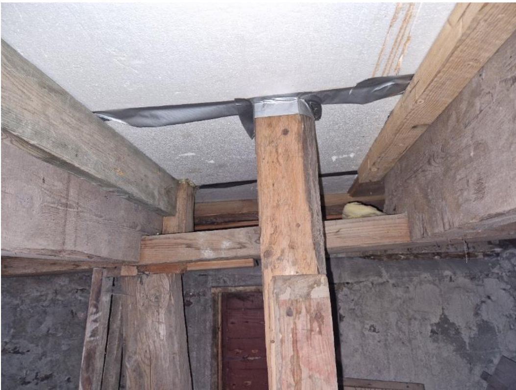
Kuva 22. Eteistilan / portaikon kohdalla ryömintätilan puolella alapohjan alapintaan on asennettu EPS-eriste.
