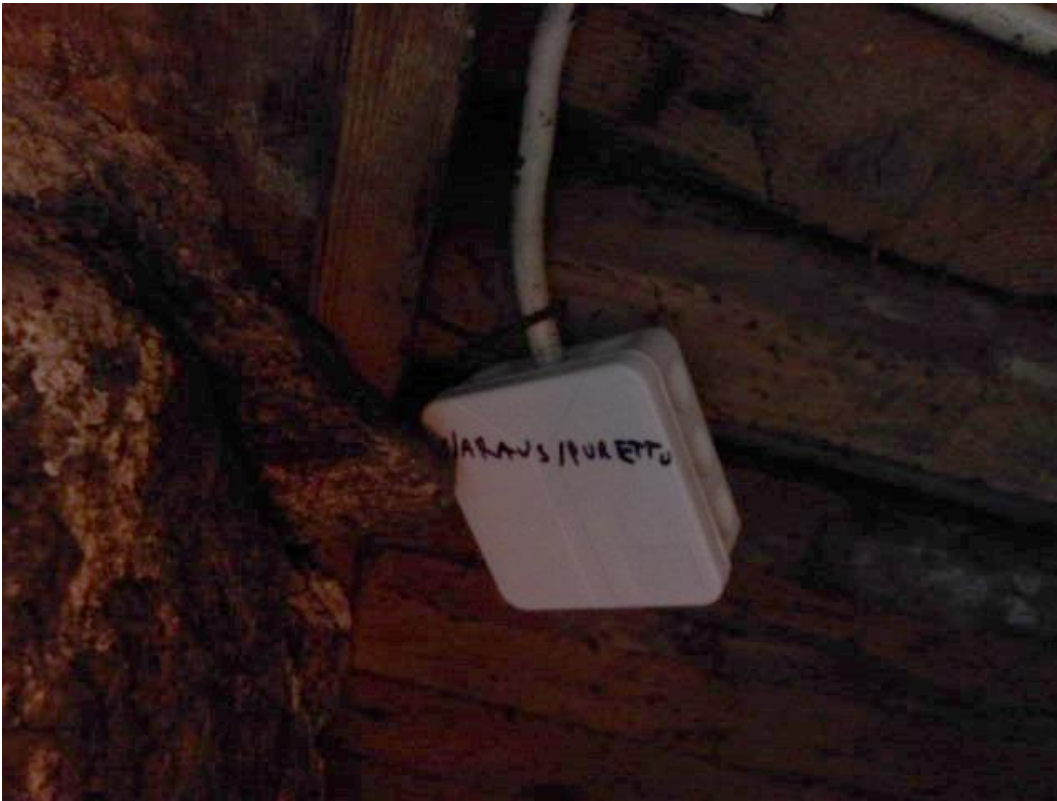
Kuva 83. Yleiskuva kellarin purettujen sähköasennuksien syöttöpisteestä.
