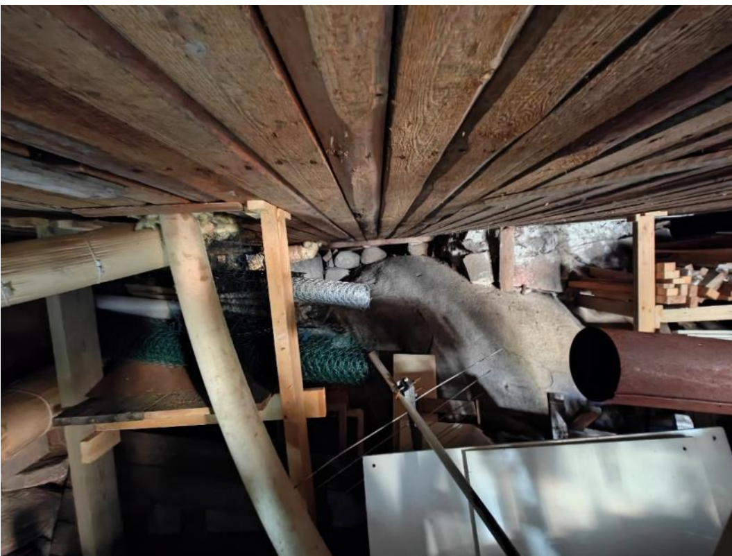
Kuva 20. Varastotilaa rakennuksen luoteispäädyssä.
