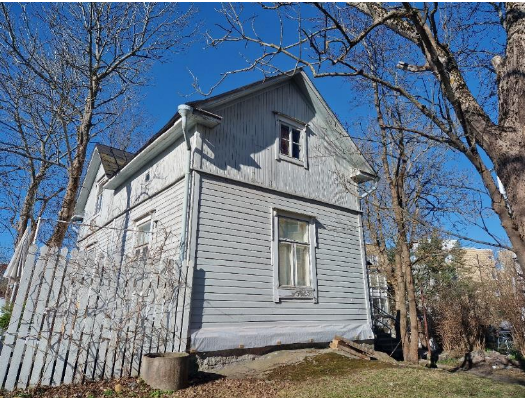
Kuva 4. Rakennuksen julkisivua koilliseen.
