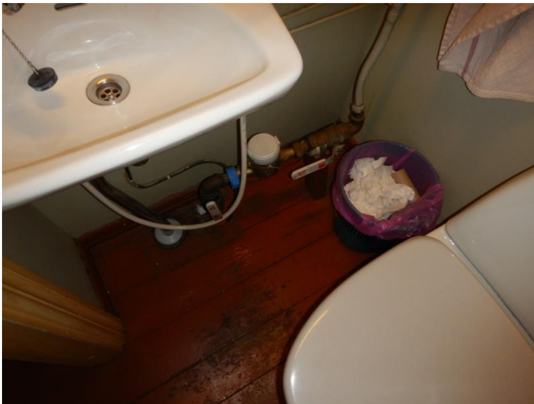
Kuva 67. Yleiskuva tonttivesijohdosta, vesimittarista ja pääsulkuventtiileistä.
