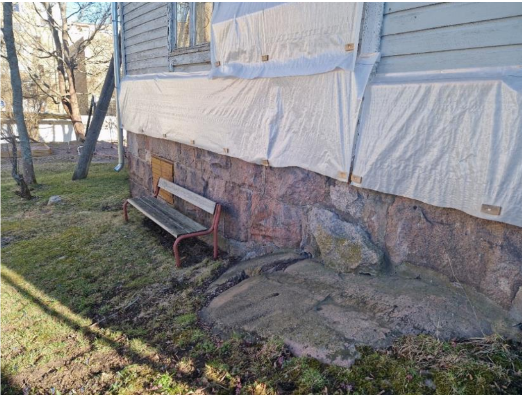
Kuva 14. Rakennuksen vierustaa lounaissivulla.
