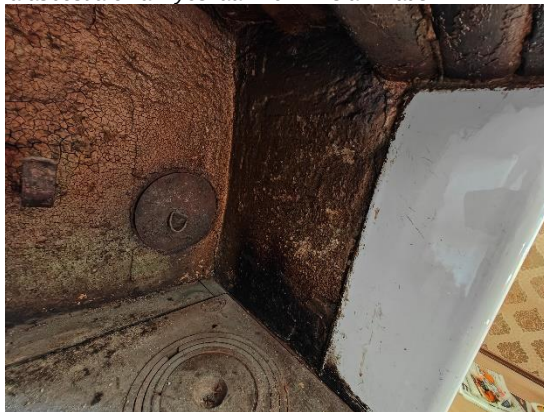
Kuva 5. Kakluunin tulitiilet, laastit ja musta pinta eivät sisällä asbestia eivätkä PAH-yhdisteitä.
