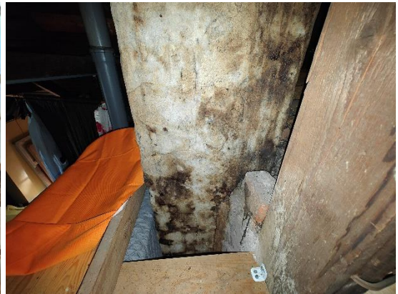
Kuva 4. Ullakon hormin slammaus ei sisällä asbestia.
