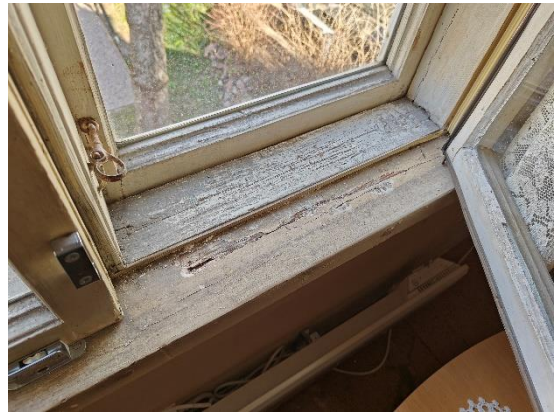
Kuva 12. Ikkunapenkkin maalit/tasoite eivät sisällä asbestia, sisältävät sinkkiä.
