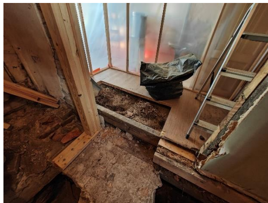
Kuva 18. Alapohja on auki sisätilan puolelta.
