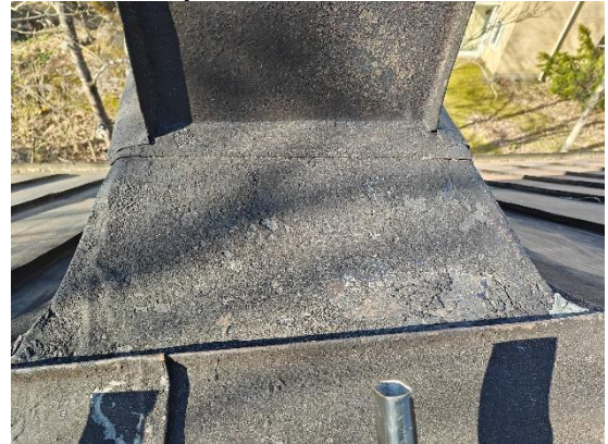
Kuvat 7 ja 8 Vesikaton piki-/bitumipinnoite ei sisällä asbestia, mutta sisältää PAH-yhdisteitä.
