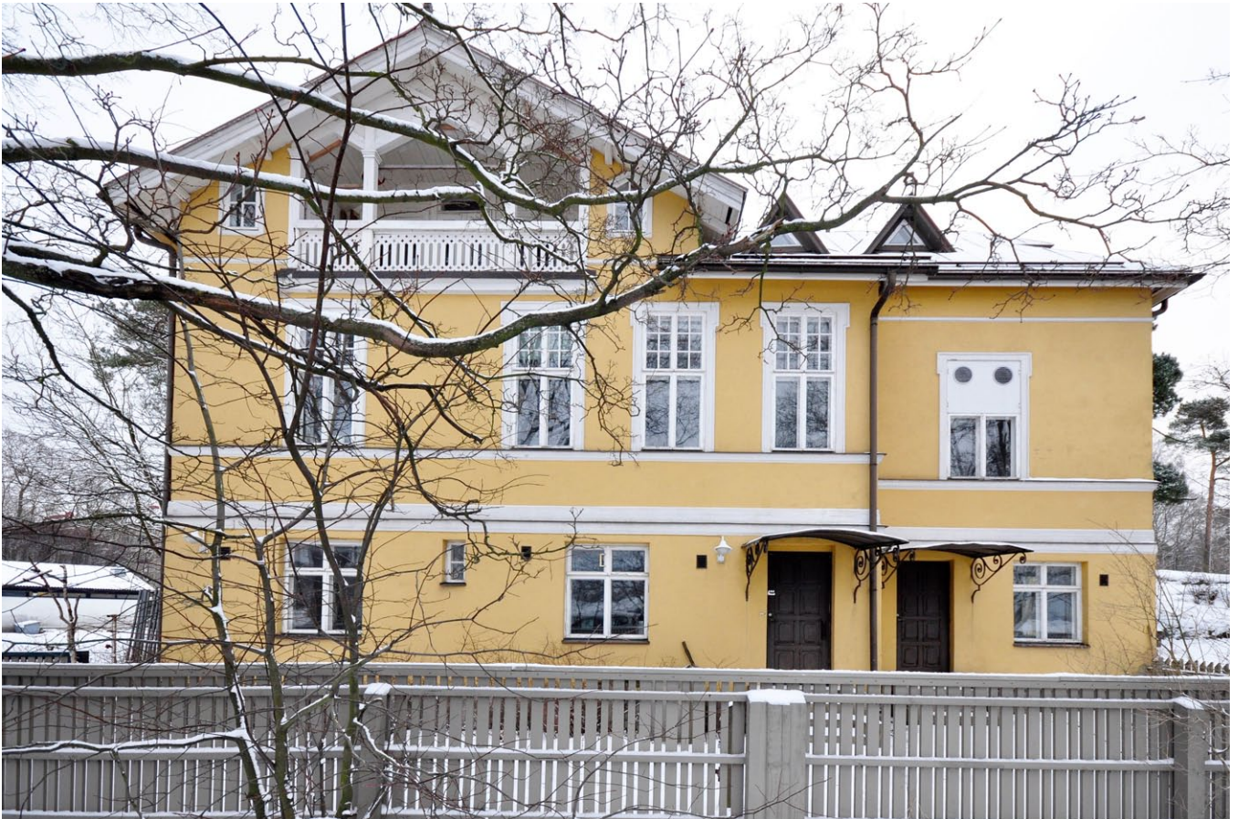
Länsijulkisivu Merikannontielle 2017. Kolmiokattoikkunat on lisätty 1983. Oikeanpuoleinen ulko-ovi ei ole käytössä, vaan sen sisäpuoli on levytetty umpeen.
