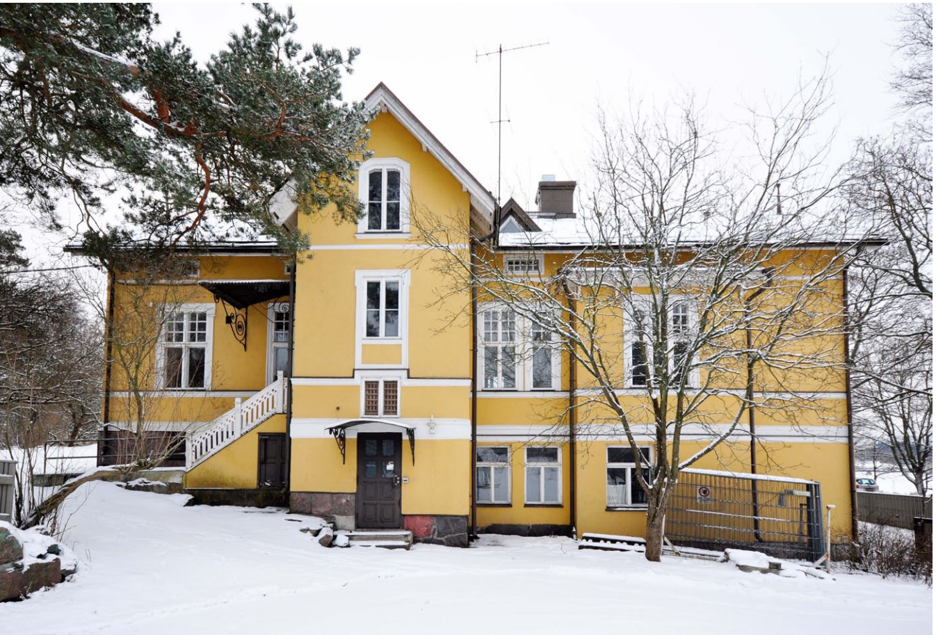
Pohjoisjulkisivu 2017. Kellarikerroksen keittiöön avautuu kolme ikkunaa.
