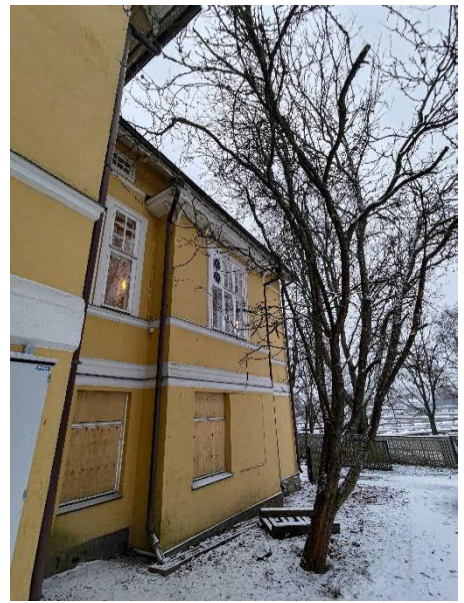
Kuva 6. ja kuva 7. Rakennuksen vierustalla on puita ja pensaita, jotka ovat aiheuttaneet julkisivulle lisääntynyttä räsitusta.
