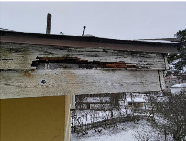
Kuva 47 ja Kuva 48. Räystäiden otsalaudoitukset ovat monin paikoin lahonneet (vas.). Yleiskuvaa pellityksen ylösnostosta julkisivulle (oik.). Pellitykset ovat vielä kohtalaisessa kunnossa.
