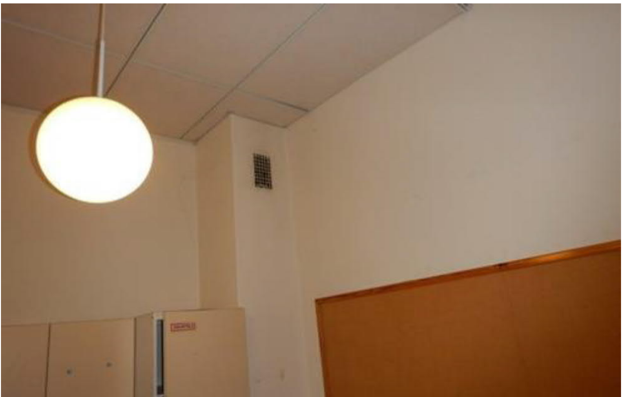
Kuva 72. Yleiskuva poistoilman valurautasäleiköstä.
