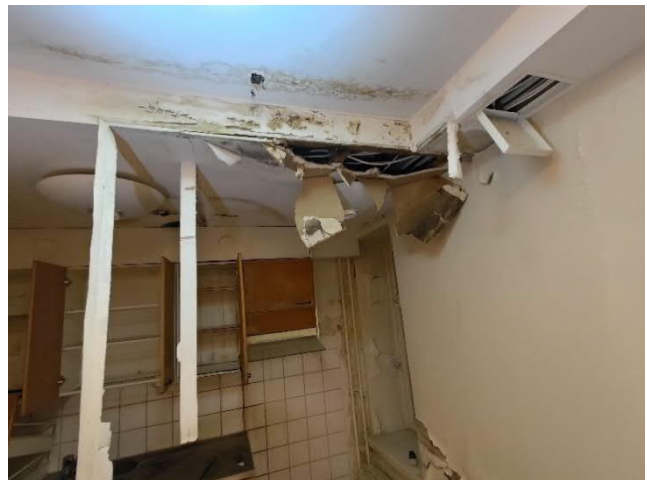
Kuva 17 ja Kuva 18. Pohja-/kellarikerroksessa laajoja kosteus- ja mikrobivaurioita.
