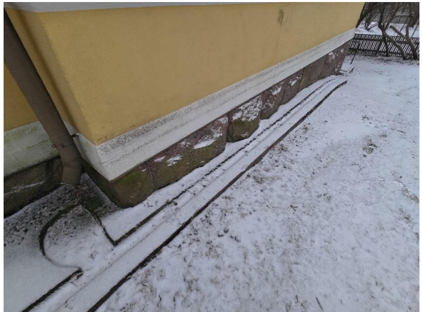
Kuva 8 ja Kuva 9. Sadevedet on ohjattu räystäskouruihin ja edelleen syöksytorvien kautta maahan tai betoniin sadevesikouruihin. Räystäskouruissa oli lehtiä ja muuta orgaanista ainesta.
