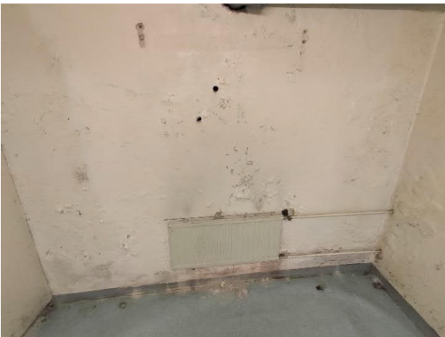
Kuva 17 ja Kuva 18. Pohja-/kellarikerroksessa laajoja kosteus- ja mikrobivaurioita.
