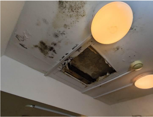
Kuva 19 ja Kuva 20. Näkyviä kosteus- ja mikrobivaurioita kellarissa (vas.) ja vanha kosteusjälki 1. kerroksen ryhmähuoneessa, rakennuksen länsinurkalla
