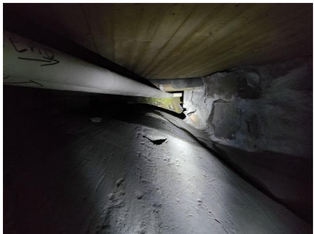
Kuva 53 ja Kuva 54. Yleiskuvaa ryömintätilasta. Ryömintätilassa esiintyy paikoittain runsaasti orgaanista materiaalia. Kalliopinnat viettävät rakennuksen perusmuuria kohti ja kalliopinnoilla havaittiin vettä.
