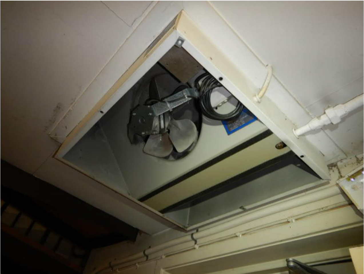
Kuva 62. Yleiskuva puhallinpatterista.
