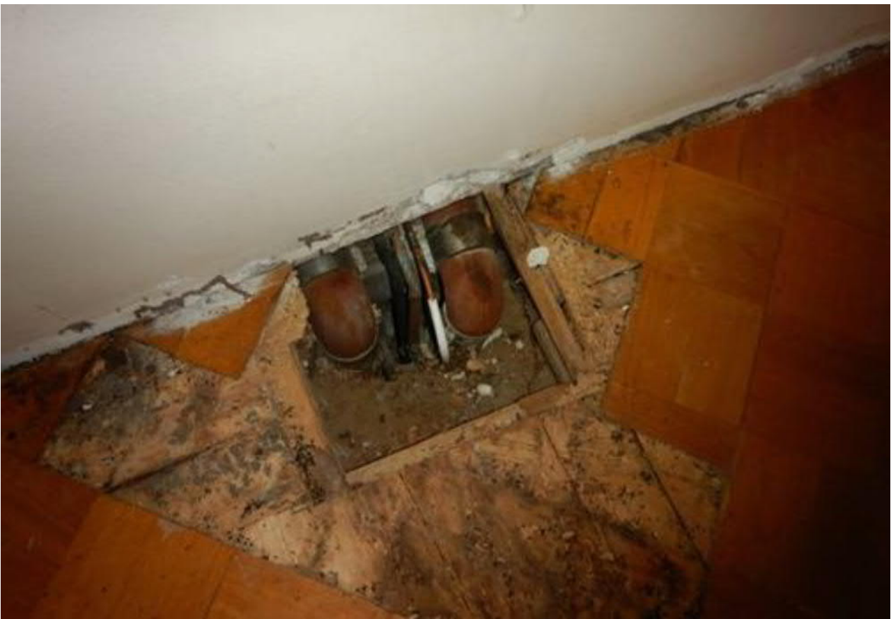
Kuva 64. Yleiskuva vesi- ja viemäriasennuksista.
