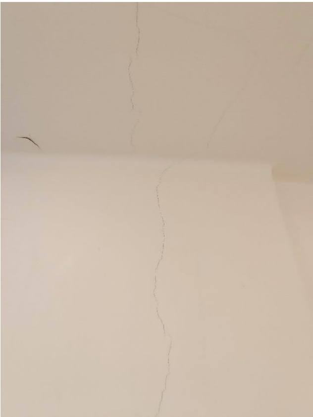
Kuva 21 ja Kuva 22. Sisäpuolisissa seinissä ja katoissa havaittiin vaihtelevan asteisia halkeamia
