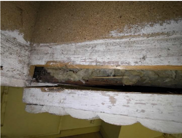
Kuva 45 ja Kuva 46. Kattoluukun liittymä yläpohja- ja vesikattorakenteisiin on epätiivis (vas.). Luukun kannen laudoitukset ovat vaurioituneet kosteudesta.
