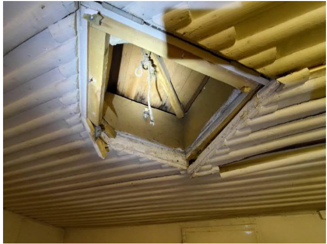
Kuva 43 ja Kuva 44. Yleiskuvaa 2. kerroksen aulatilasta. Tilassa oleva kulkuluukusta ei ollut pääsyä ullakkotiilaan. Tilassa on roskaa ja lehtiä (vas.). Vesikaton johtava kattoluukku on turvonnut umpeen, eikä vesikatolle ollut sisäkautta pääsyä.
