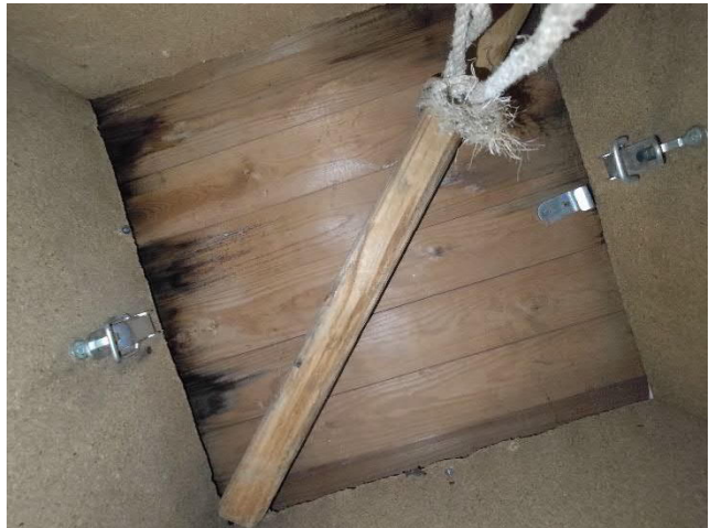
Kuva 45 ja Kuva 46. Kattoluukun liittymä yläpohja- ja vesikattorakenteisiin on epätiivis (vas.). Luukun kannen laudoitukset ovat vaurioituneet kosteudesta.
