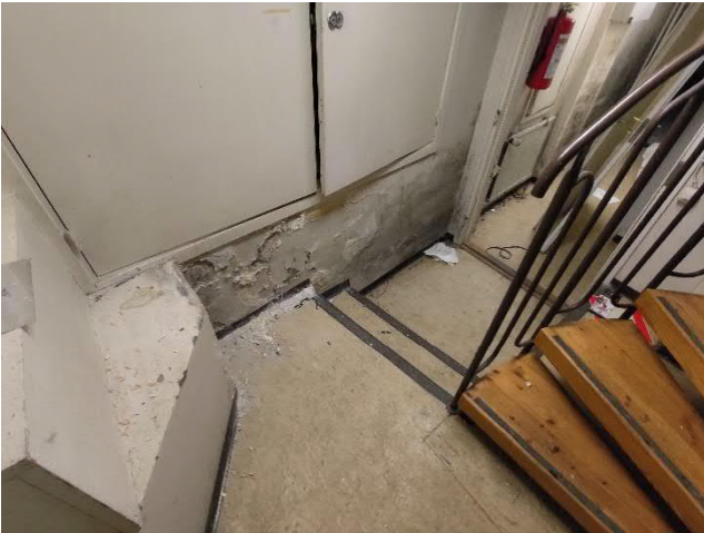
Kuva 15. ja kuva 16. Sisäseinissä laajoja kosteus- ja mikrobivaurioita.
