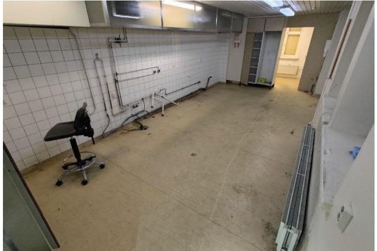
Kuvat 13. ja 14. Rakennuksen pohjakerroksessa/kellarikerroksessa lattioiden pintamateriaali on pääsääntöisesti muovimattoja. Rakennekerroksista ei ole tarkempaa tietoa.
