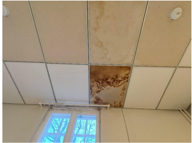
Kuva 19 ja Kuva 20. Näkyviä kosteus- ja mikrobivaurioita kellarissa (vas.) ja vanha kosteusjälki 1. kerroksen ryhmähuoneessa, rakennuksen länsinurkalla
