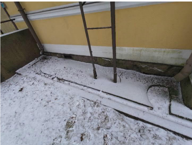
Kuva 51 ja Kuva 52. Katolle johtavissa tikkaissa ei ole kiipeilyestettä (vas.). Yleiskuvaa vesikaton läpiviennistä (oik.)
