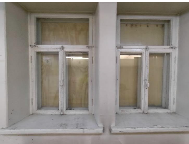
Kuva 27 ja Kuva 28. Pohjakerrosten ikkunoiden suojaksi on asennettu vanerilevyt. 1. kerroksen osalla havaittiin useammissa ikkunoissa kosteutta lasien pinnalla.
