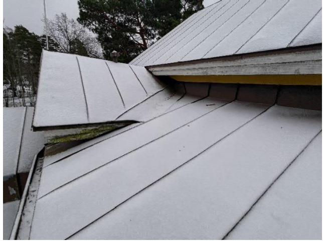
Kuva 49 ja Kuva 50. Yleiskuvaa vesikatolta. Kulkusillat ovat pääosin vielä kohtalaisessa kunnossa. Piipunhatut puuttuvat. Räystäslaudoitusten kunto vaihtelee ja monin paikoin laudoituksen pinnalla kasvaa levää.
