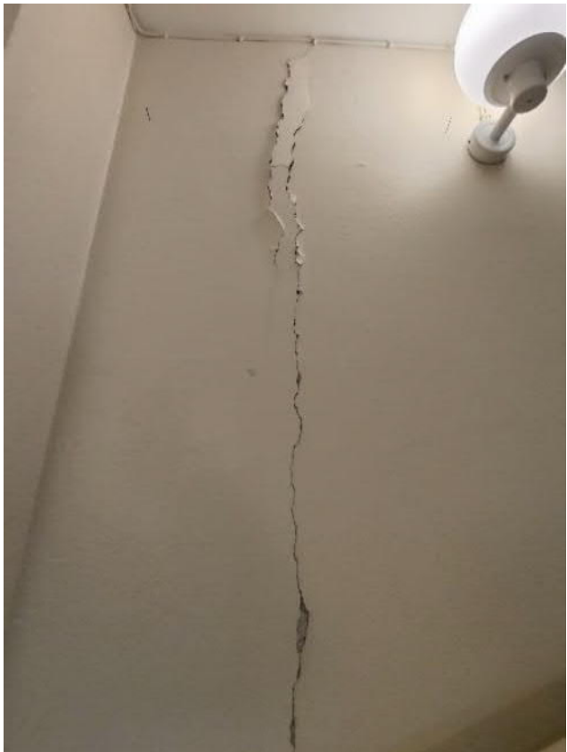
Kuva 21 ja Kuva 22. Sisäpuolisissa seinissä ja katoissa havaittiin vaihtelevan asteisia halkeamia
