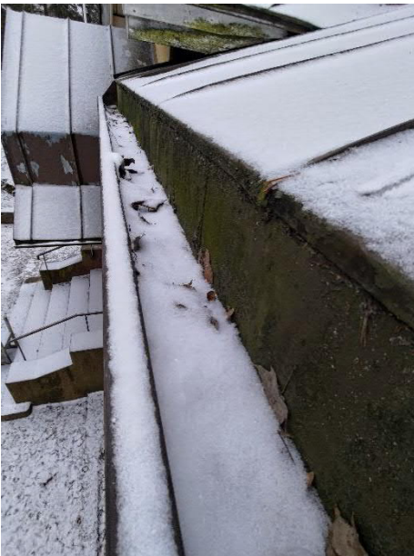
Kuva 8 ja Kuva 9. Sadevedet on ohjattu räystäskouruihin ja edelleen syöksytorvien kautta maahan tai betoniin sadevesikouruihin. Räystäskouruissa oli lehtiä ja muuta orgaanista ainesta.
