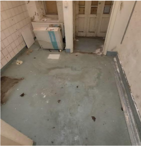
Kuvat 13. ja 14. Rakennuksen pohjakerroksessa/kellarikerroksessa lattioiden pintamateriaali on pääsääntöisesti muovimattoja. Rakennekerroksista ei ole tarkempaa tietoa.
