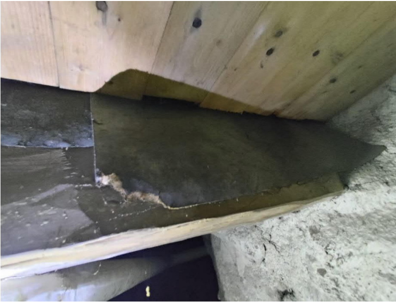
Kuva 55 ja Kuva 56. Puualapohjarakenne ryömintätilasta käsin kuvattuna. Välipohjarakenteessa on tervapahvia (vas.). Ryömintätilassa perusmuuria kohti kaatava kallionpinta on märkä.
