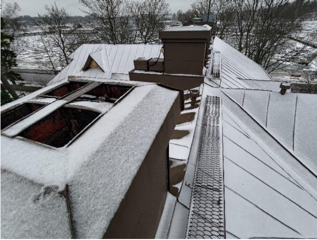
Kuva 49 ja Kuva 50. Yleiskuvaa vesikatolta. Kulkusillat ovat pääosin vielä kohtalaisessa kunnossa. Piipunhatut puuttuvat. Räystäslaudoitusten kunto vaihtelee ja monin paikoin laudoituksen pinnalla kasvaa levää.
