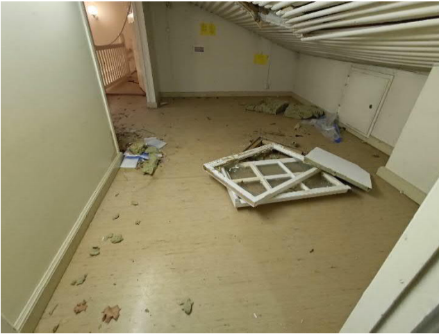
Kuva 43 ja Kuva 44. Yleiskuvaa 2. kerroksen aulatilasta. Tilassa oleva kulkuluukusta ei ollut pääsyä ullakkotiilaan. Tilassa on roskaa ja lehtiä (vas.). Vesikaton johtava kattoluukku on turvonnut umpeen, eikä vesikatolle ollut sisäkautta pääsyä.
