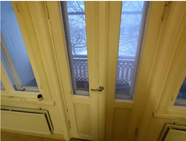
Kuva 41 ja Kuva 42. Parvekkeen ovet on osin teljetty kiinni ja osin ne ovat turvonneet umpeen. Parvekkeilla on runsaasti lehtiä ja muuta roskaa.
