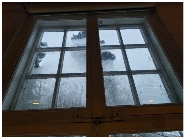
Kuva 27 ja Kuva 28. Pohjakerrosten ikkunoiden suojaksi on asennettu vanerilevyt. 1. kerroksen osalla havaittiin useammissa ikkunoissa kosteutta lasien pinnalla.
