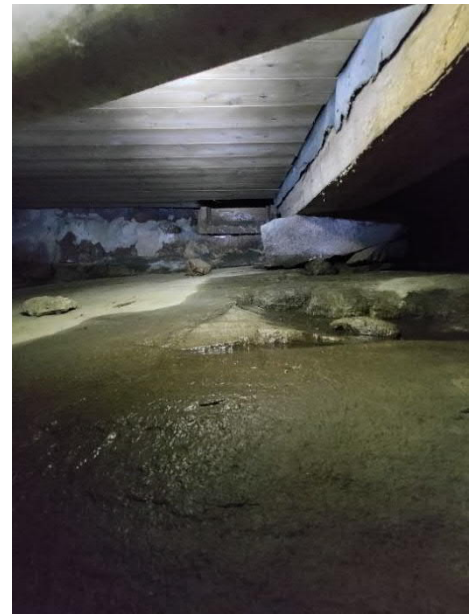
Kuva 55 ja Kuva 56. Puualapohjarakenne ryömintätilasta käsin kuvattuna. Välipohjarakenteessa on tervapahvia (vas.). Ryömintätilassa perusmuuria kohti kaatava kallionpinta on märkä.
