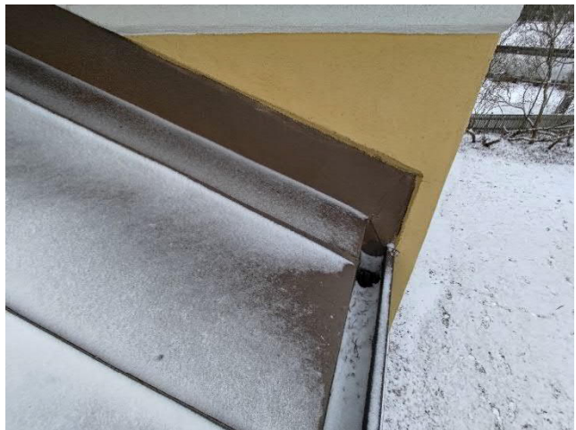
Kuva 47 ja Kuva 48. Räystäiden otsalaudoitukset ovat monin paikoin lahonneet (vas.). Yleiskuvaa pellityksen ylösnostosta julkisivulle (oik.). Pellitykset ovat vielä kohtalaisessa kunnossa.
