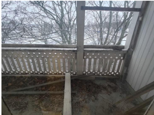
Kuva 41 ja Kuva 42. Parvekkeen ovet on osin teljetty kiinni ja osin ne ovat turvonneet umpeen. Parvekkeilla on runsaasti lehtiä ja muuta roskaa.
