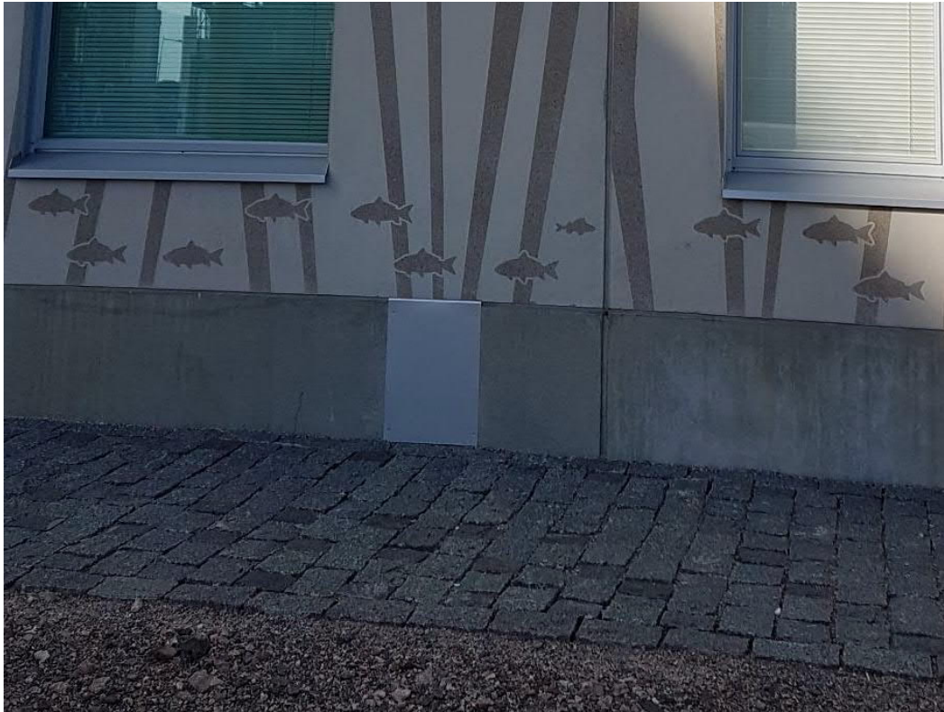
Kotelon varausaukko asennettu maanpinnan tasolle, vaikka kuuluisi olla pinnasta +600mm. Alla olevissa kuvissa kotelo on sijoitettu parvekkeen puolelle tai kotelonpeitelevy on kotelon kokoon nähden massiivinen.
