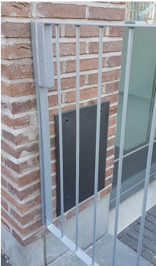
Kotelon varausaukko asennettu maanpinnan tasolle, vaikka kuuluisi olla pinnasta +600mm. Alla olevissa kuvissa kotelo on sijoitettu parvekkeen puolelle tai kotelonpeitelevy on kotelon kokoon nähden massiivinen.
