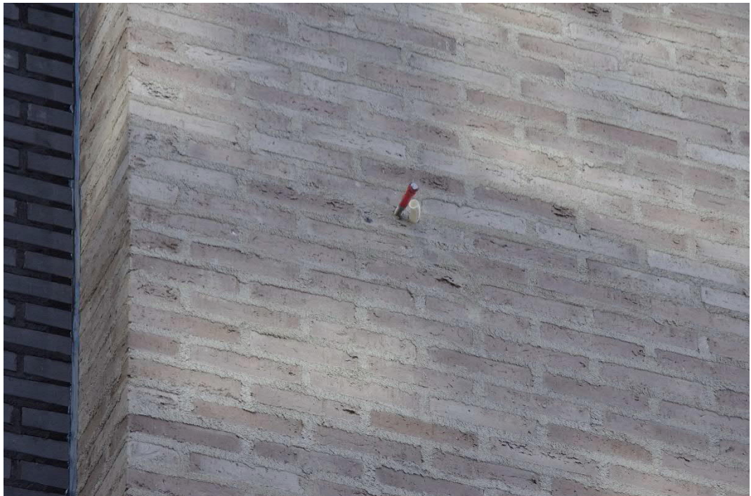
Kierretanko seinässä ja kotelolta tuleva nousuputki kierretangolle.
