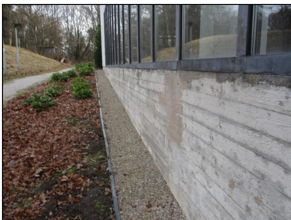
5.6 Sokkelirakennetta on paikkakorjattu aikojen saatossa
