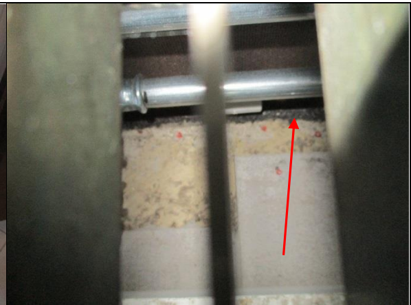
9.2 Koteloinnin alla mustaa pinnoitetta
