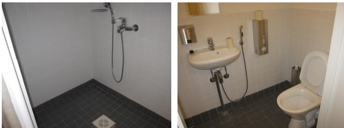
Kuvat 14 ja 15: Suihku- ja WC-tilojen lattiat olivat kaakelipintaiset
