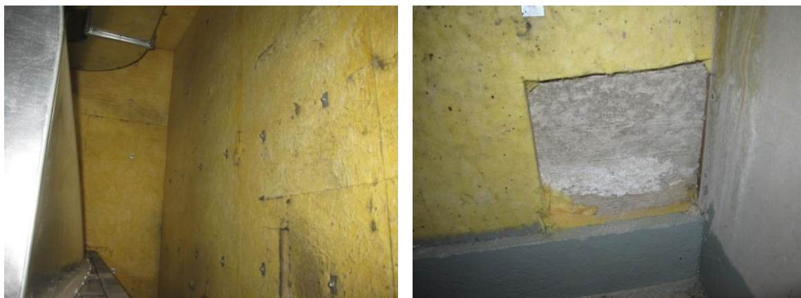
Kuvat 19 ja 20: IV-konehuoneen seinien villaeriste, oikealla näytteenotto kohta
