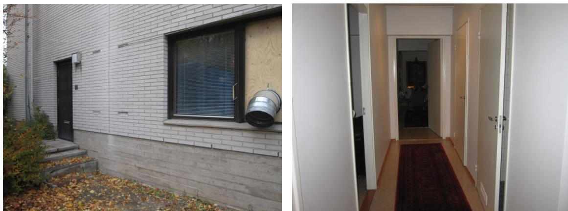
Kuvat 3 ja 4: Asunnon sisäänkäynti ja käytävä
