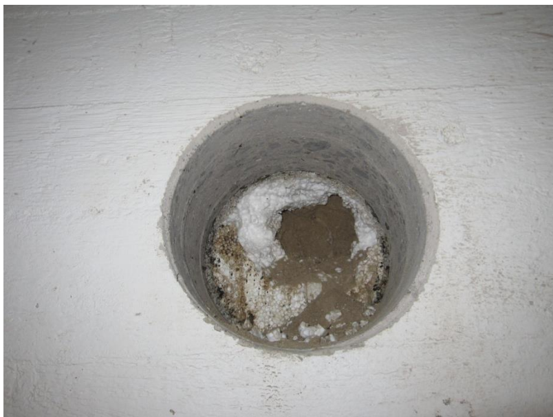
Kuva 18: Rakenneavaus varastotilan takaseinään, takana maatyttö
