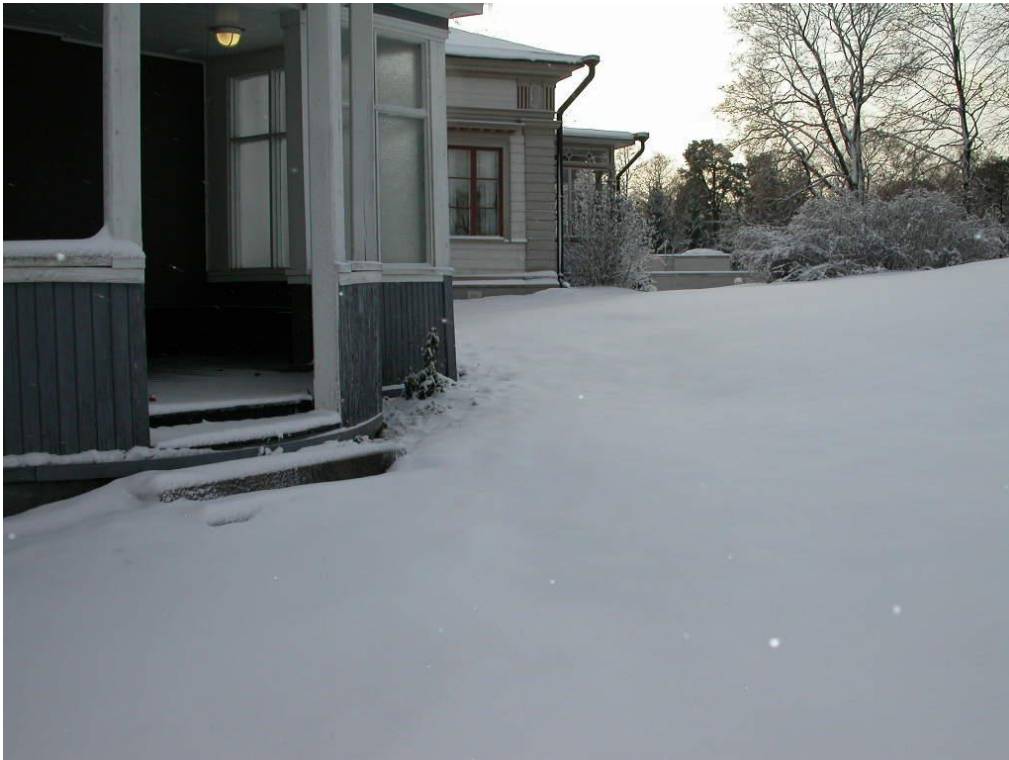
Kuva 7. Maan pinta rakennuksen lounaispäädyssä viettää rakennukseen päin. Maan pinta sijaitsee lattian yläpinnan tasossa.
