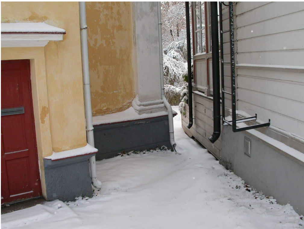
Kuva 8. Kattovedet johdetaan sokkelirakenteen viereen.
