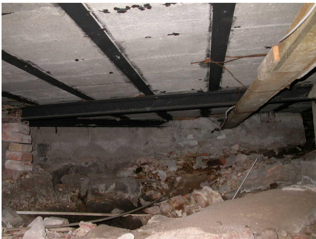
Kuva 2. Ryömintätilan maapohja on epätasainen. Ryömintätilassa on vähäinen määrä sinne kuulumatonta jätettä.
