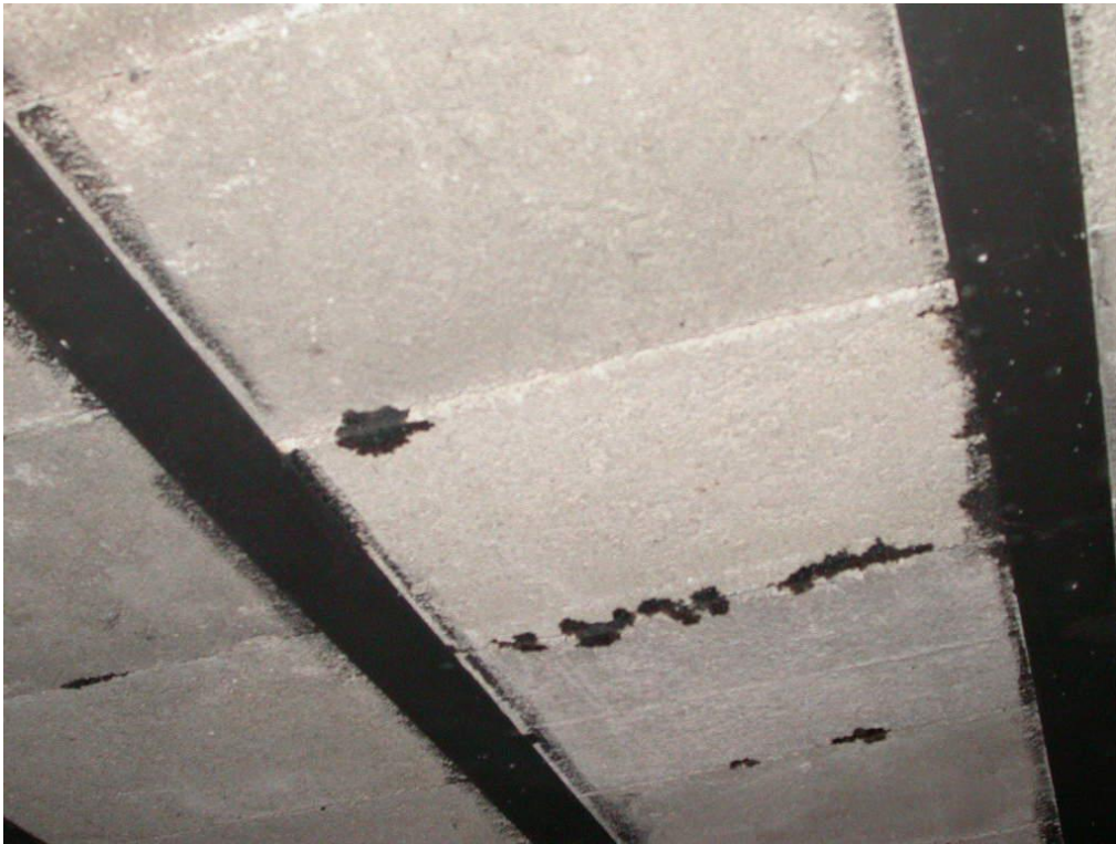
Kuva 9. Alapohjan alapinta muodostuu erillisistä betonilaatoista. Laataston yläpintaan on tehty bitumisively.
