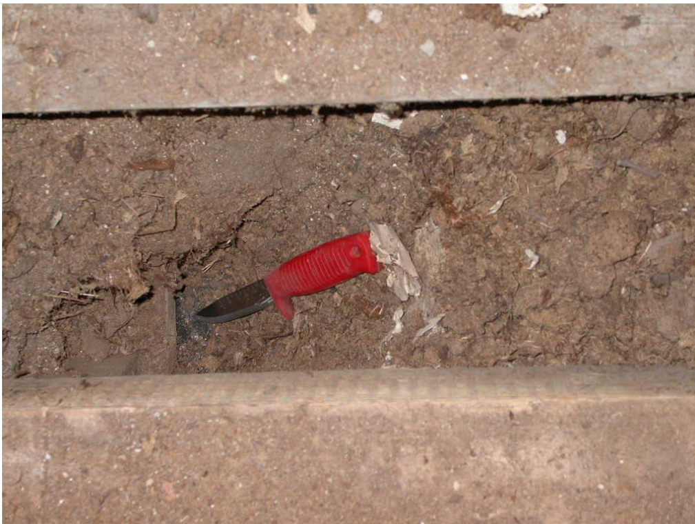
Kuva 12. Alapohjan betonilaatan päällä on paikoin bitumikermi ja paikoin bitumisively.
