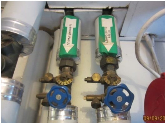
Linjasäätöventtiilit
