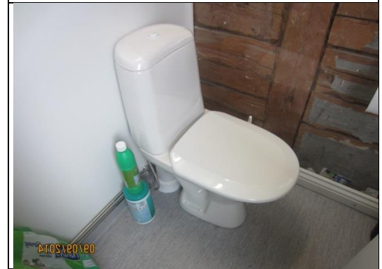
Uusittu WC- istuin
