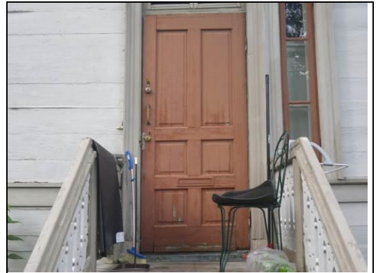
Maalivaurioita autotallin ovesa
