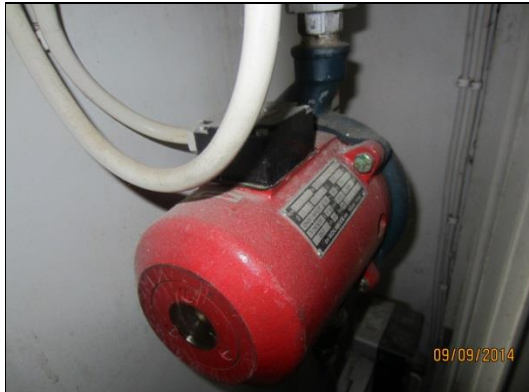
Tuloilmakoneen kiertovesipumppu
