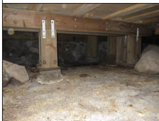
Uusittu alapohjarakennetta
