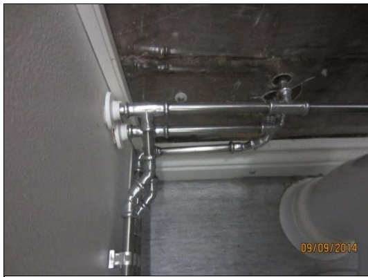
Kromisia uusittuja kalusteiden kytkentäjohdot
