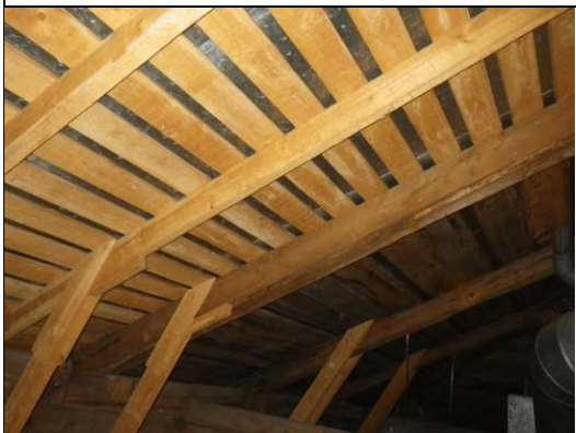
Uusittua vesikatteen aluslaudoitusta.
