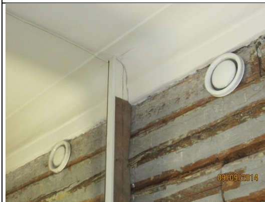
Asiakasvessan poistoilmaventtiilit
