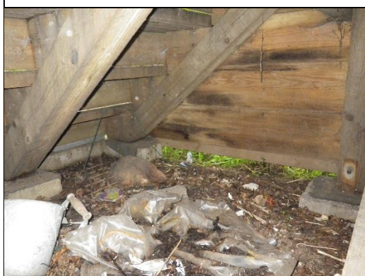
Keittiön johtavat ulkoportaat
