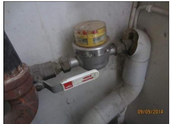
Päävesimittari
