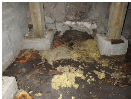
Rakennusjätettä alapohjassa
