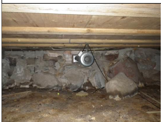
Alapohjan koneellinen poisto
