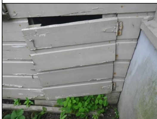
Keittiön ulkoportaiden luukku
