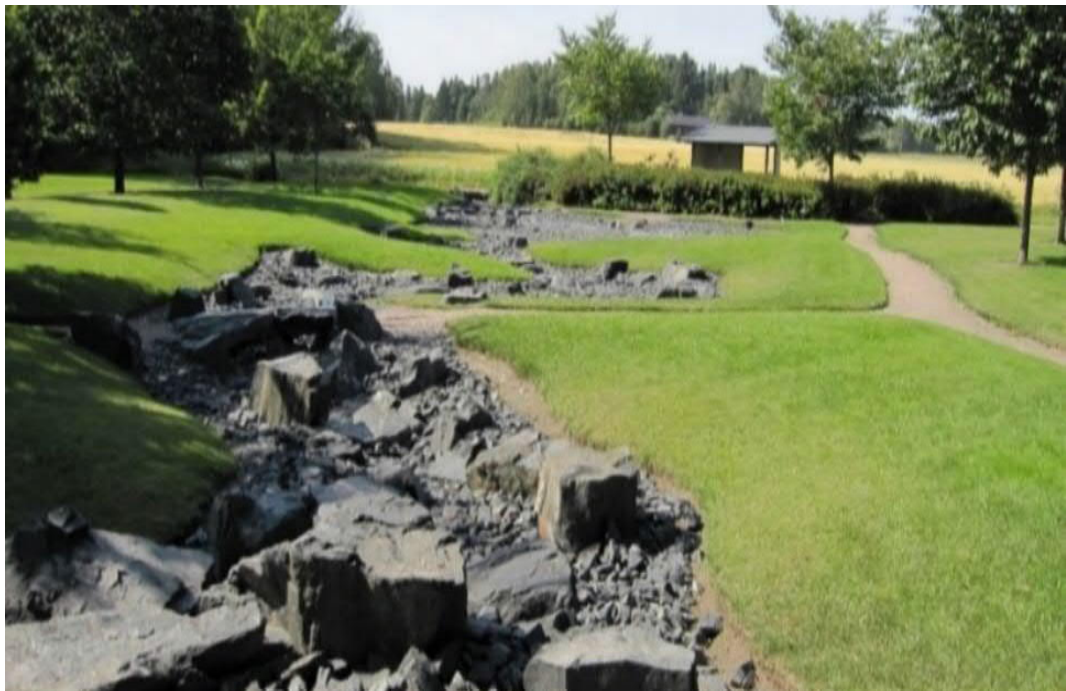
Kuva 1. Hulevesien viivytyksrakenne Eko-Viikissä.
